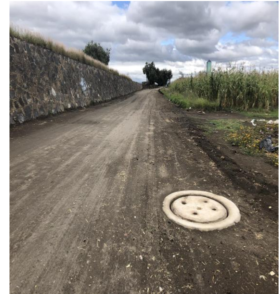
OBRA TERMINADA, POZO DE VISITA PARA VENTILACIÓN Y MANTENIMIENTO DE LA LINEA DEL SUBCOLECTOR
