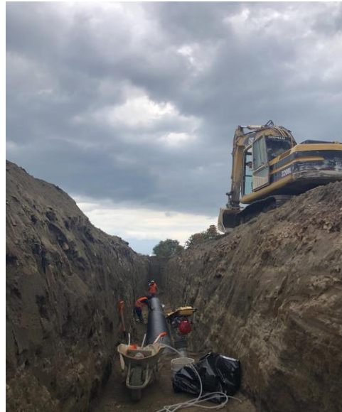
CONFORMACIÓN DE RELLENO EN ZANJAS Y COMPACTACIÓN
