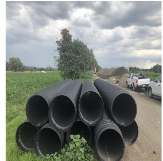
SUMINISTRO DE TUBERÍA CORRUGADA DE POLIETILENO DE ALTA DENSIDAD (P.E.A.D.) DE 24" DE DIAMETRO PARA ALCANTARILLADO SANITARIO
