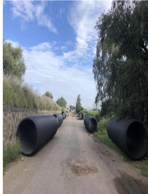
SUMINISTRO DE TUBERÍA CORRUGADA DE POLIETILENO DE ALTA DENSIDAD (P.E.A.D.).DE 48" DE DIAMETRO PARA ALCANTARILLADO SANITARIO
