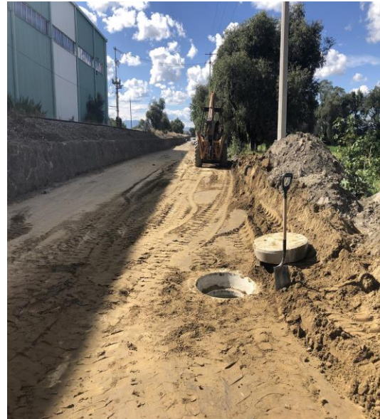
CONSTRUCCIÓN DE POZOS DE VISTA TIPO ESPECIAL
