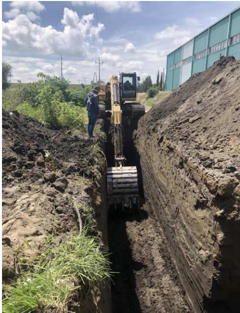
TRABAJOS DE EXCAVACIÓN DE ZANJA CON EQUIPO
