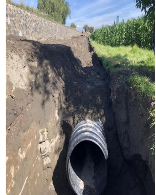
INSTALACIÓN DE TUBERÍA CORRUGADA DE POLIETILENO DE ALTA DENSIDAD (P.E.A.D.).DE 48" DE DIAMETRO PARA ALCANTARILLADO SANITARIO
