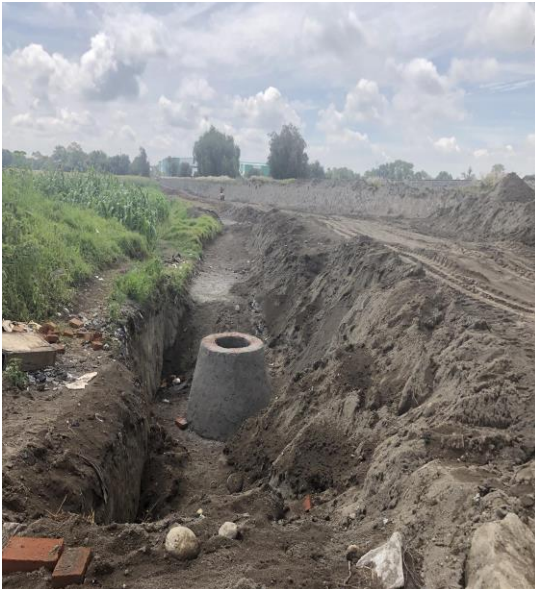
CONFORMACIÓN DE RELLENO EN ZANJAS
