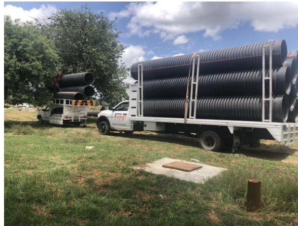
SUMINISTRO DE TUBERÍA CORRUGADA DE POLIETILENO DE ALTA DENSIDAD (P.E.A.D.) PARA ALCANTARILLADO SANITARIO
