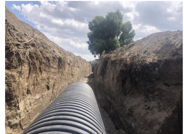
INSTALACIÓN DE TUBERÍA CORRUGADA DE POLIETILENO DE ALTA DENSIDAD (P.E.A.D.) PARA ALCANTARILLADO SANITARIO
