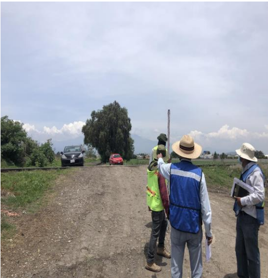
VERIFICACIÓN DE NIVELES Y TRAZO DE PROYECTO
