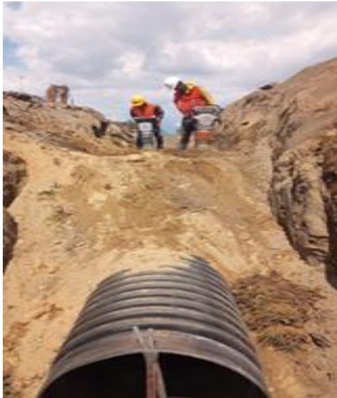
INSTALACIÓN DE TUBERÍA CORRUGADA (P.E.A.D.).DE 24" DE DIAMETRO, PARA ALCANTARILLADO SANITARIO
