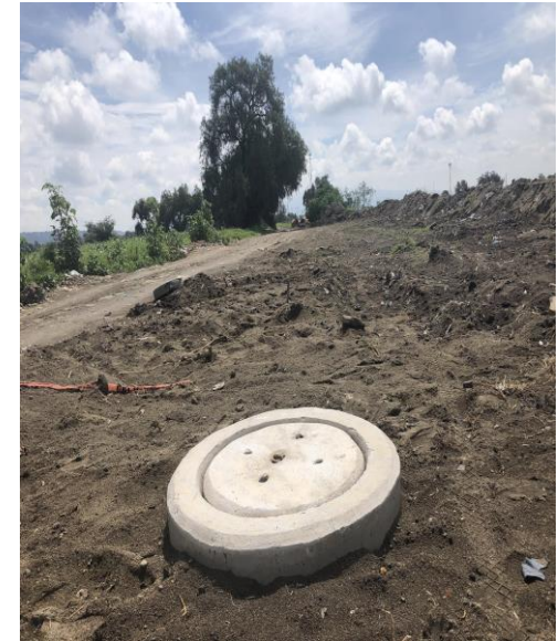
OBRA TERMINADA, POZO DE VISITA PARA VENTILACION Y MANTENIMIENTO DE LA LINEA DEL SUBCOLECTOR
