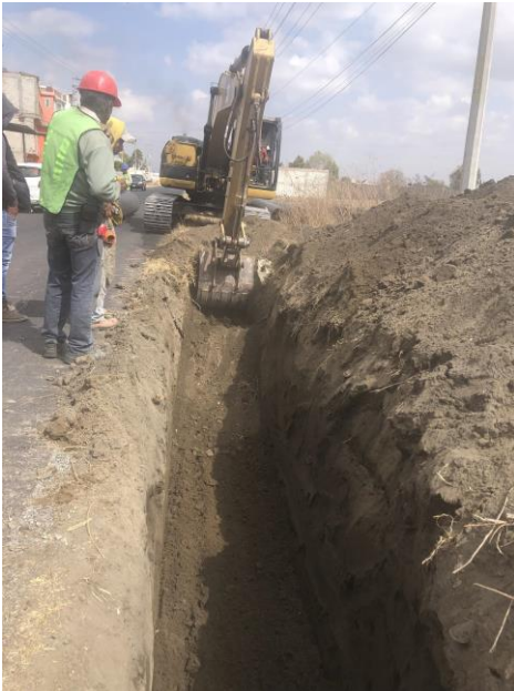
TRABAJOS DE EXCAVACIÓN DE ZANJA CON EQUIPO
