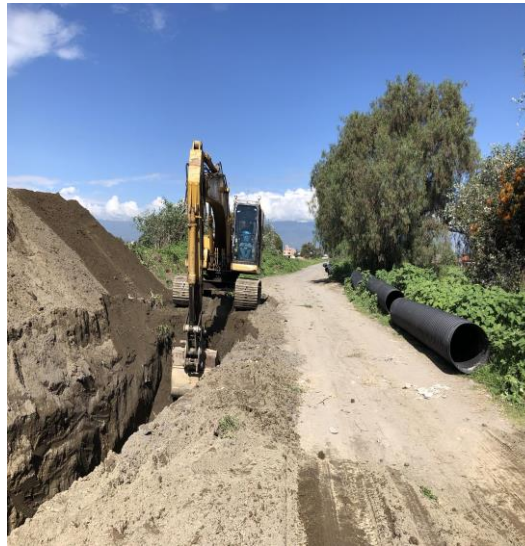
TRABAJOS DE EXCAVACIÓN DE ZANJA CON EQUIPO
