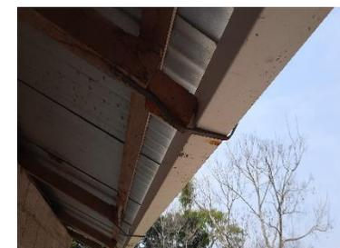
COLOCACIÓN DE LA CANALETA PARA LA CAPTACIÓN DE LLUVIA
