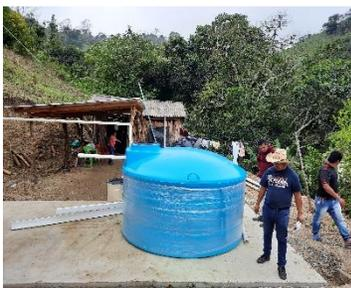
COLOCACIÓN DE CISTERNAS CON SUS INSTALACIONES HIDRÁULICAS
