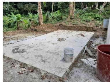
CONSTRUCCIÓN DE LOSA PARA LA COLOCACIÓN DE LAS CISTERNAS
