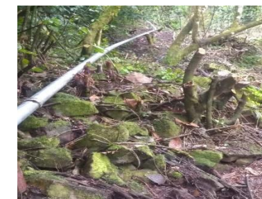
COLOCACIÓN DE LA TUBERÍA GALVANIZADA
