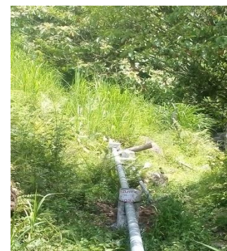
OBRA EN PROCESO CON LA REHABILITACIÓN DE LA LÍNEA DE CONDUCCIÓN Y LA CONSTRUCCIÓN DE ATRAQUES
