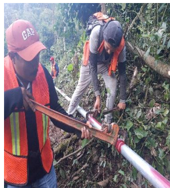
LIMPIA, TRAZO, NIVELACIÓN Y COLOCACIÓN DE TUBERÍA DE Fo.Go. DE 2” DE DIÁMETRO
