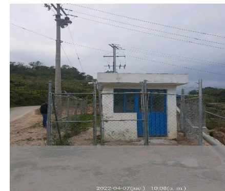
TERMINACIÓN DE OBRA
