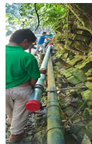
INSTALACION DE TUBERIA GALVANIZADA DE 4" PARA LA LÍNEA DE CONDUCCIÓN
