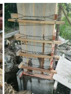
ETAPA DE PROCESO DE REHABILITACIÓN DE LÍNEA DE CONDUCCIÓN, HABILITADO DE ACERO PARA ZAPATAS Y ATRAQUE EN COLUMNAS Y ATRAQUES EN CADA MARGEN DE RIO PARA CRUZAR LA LÍNEA DE CONDUCCIÓN A TRAVÉS DEL RIO TECOLUTLA
