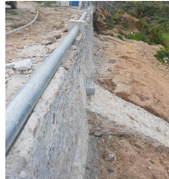
LIMPIA, TRAZO, NIVELACIÓN Y CONSTRUCCIÓN DE MURO DE CONTENCIÓN DE MAMPOSTERÍA
