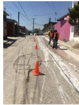
ETAPA DE INICIO DE OBRA CON ACTIVIDADES DE LIMPIEZA, TRAZO Y RUPTURA Y DEMOLICIÓN DE PAVIMENTO Y DE LA ZONA DONDE SE CONSTRUIRÁ EL SISTEMA DE AGUA
