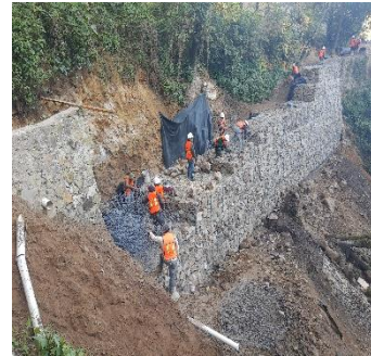
CONSTRUCCIÓN DE MURO GAVIÓN A BASE DE JAULAS DE MALLA Y PIEDRA BRASA
