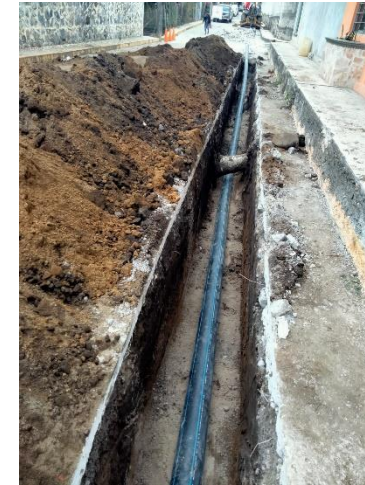
ETAPA DEL PROCESO DE LA OBRA CON EXCAVACIONES Y COLOCACIÓN DE TUBERÍA
