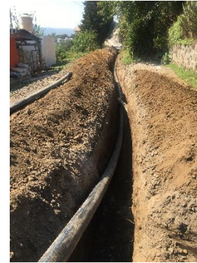
ETAPA DEL PROCESO DE LA OBRA CON EXCAVACIONES Y COLOCACIÓN DE TUBERÍA
