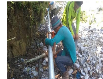
SUMINISTRO Y COLOCACIÓN DE TUBERÍA GALVANIZADA
