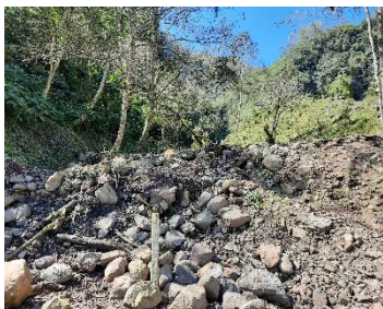
VERIFICACIÓN DE LOS TRABAJOS
