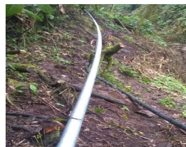
OBRA TERMINADA DE LA COLOCACIÓN DE TUBERÍA
