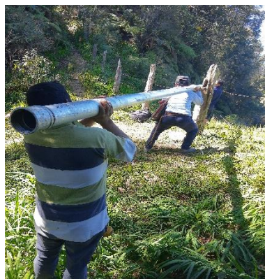
SUMINISTRO DE TUBERÍA Fo.Go. DE 3" DE DIÁMETRO
