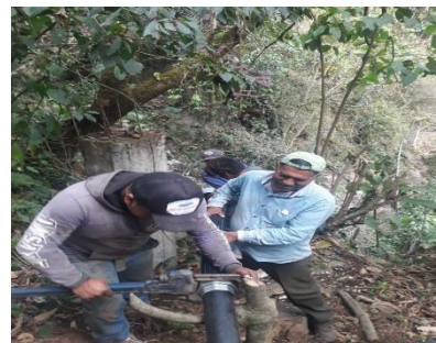
INSTALACIÓN DE TUBERÍA DE ALTA DENSIDAD
