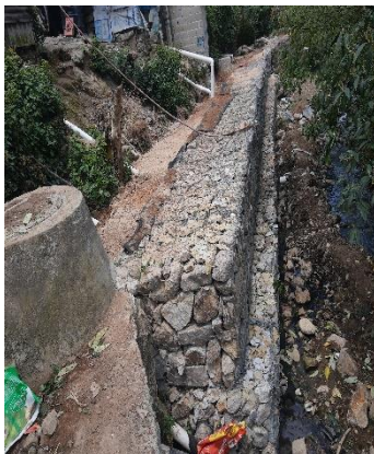
CONSTRUCCIÓN DE MURO GAVIÓN POZO DE VISITA E INSTALACIÓN DE TUBERÍA ADS DE 18"
