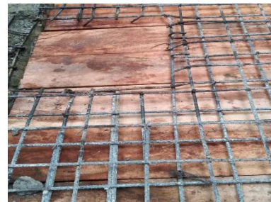
SUMINISTRO, HABILITADO Y COLOCACIÓN DE CIMBRA DE MADERA
