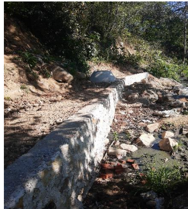
LIMPIA, TRAZO Y EXCAVACIÓN E INSTALACIÓN DE TUBERÍA ADS DE 18" Y CONSTRUCCIÓN DE MURO DE MAMPOSTERIA.
