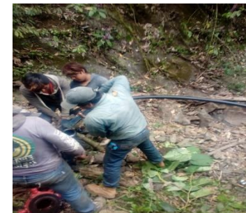
TRABAJOS DE TUBERIA POLIETILENO ALTA DENSIDAD
