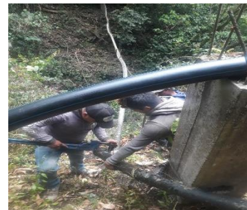
COLOCACIÓN E INSTALACIÓN DE TUBERIA POLIETILENO ALTA DENSIDAD
