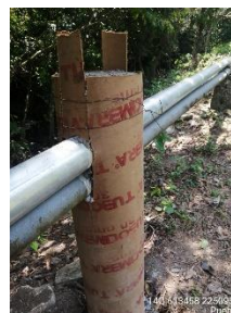
CONSTRUCCIÓN DE ATRAQUES DE CONCRETO
