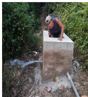
CONSTRUCCIÓN DE ATRAQUES PARA SOPORTAR LA TUBERÍA DE 2” DE DIÁMETRO
