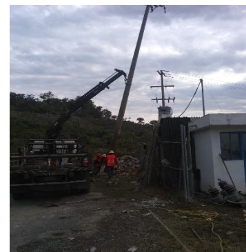
TRABAJANDO EN LA COLOCACIÓN DE POSTE DE LUZ
