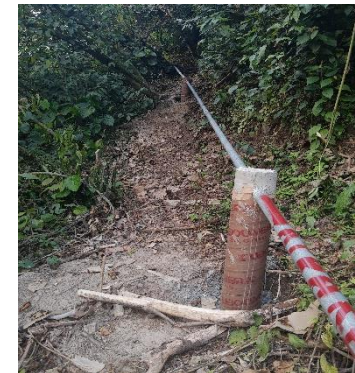
CONSTRUCCIÓN DE ATRAQUES PARA SOPORTE DE LA TUBERÍA
