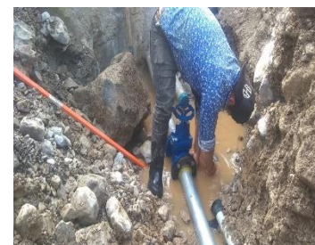
TRABAJOS DE TUBERÍA Y COLOCACIÓN
