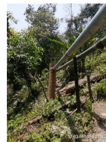
OBRA TERMINADA DE LA REHABILITACIÓN DE LÍNEA DE CONDUCCIÓN
