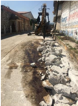
ETAPA DE INICIO DE OBRA CON ACTIVIDADES DE LIMPIEZA, TRAZO Y RUPTURA Y DEMOLICIÓN DE PAVIMENTO Y DE LA ZONA DONDE SE CONSTRUIRÁ EL SISTEMA DE AGUA
