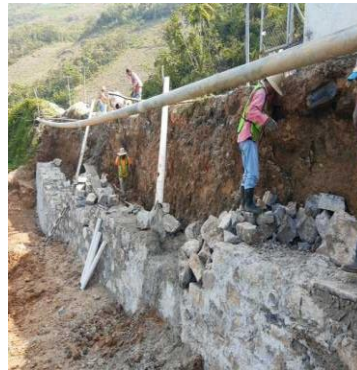
LIMPIA, TRAZO, NIVELACIÓN Y CONSTRUCCIÓN DE MURO DE CONTENCIÓN DE MAMPOSTERÍA
