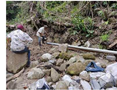
OBRA EN PROCESO REHABILITACIÓN DE LA LÍNEA DE CONDUCCIÓN EN EL RIO TECOLUTLA
