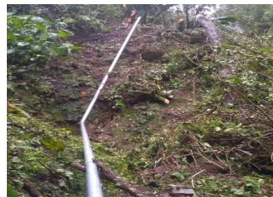
TRABAJOS TERMINADOS EN LA COLOCACIÓN DE TUBERÍA EN EL LUGAR
