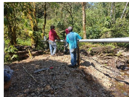
OBRA EN PROCESO CON LA REHABILITACIÓN DE LA LÍNEA DE CONDUCCIÓN Y LA CONSTRUCCIÓN DE ATRAQUES
