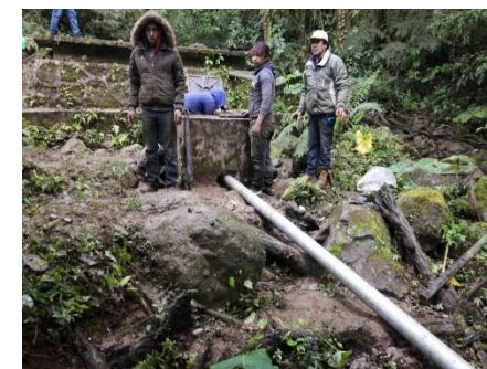
OBRA EN PROCESO CON LA REHABILITACIÓN DE LA LÍNEA DE CONDUCCIÓN Y LA CONSTRUCCIÓN DE ATRAQUES
