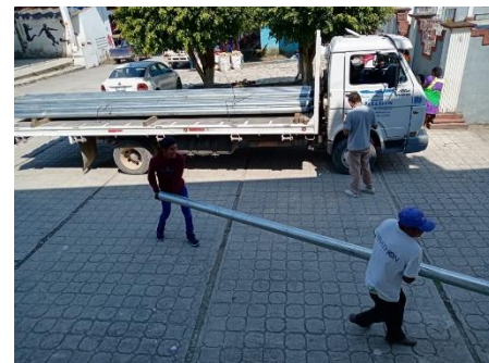
OBRA EN PROCESO CON EL SUMINISTRO DE TUBERÍA Y REHABILITACIÓN DE LA LÍNEA DE CONDUCCIÓN
