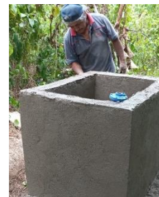
CONSTRUCCIÓN DE CAJA PARA OPERACIÓN DE VÁLVULAS
