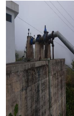
TERMINACIÓN DE MURO DE MAMPOSTERÍA, CONSTRUCCIÓN DE ATRAQUES Y COLOCACIÓN DE TUBERÍA DE Fo. De 6" DE DIÁMETRO
