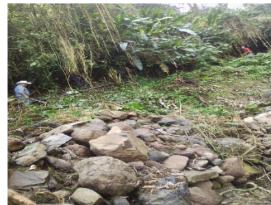
LUGAR DE LOS TRABAJOS DE LA LINEA DE CONDUCCIÓN
