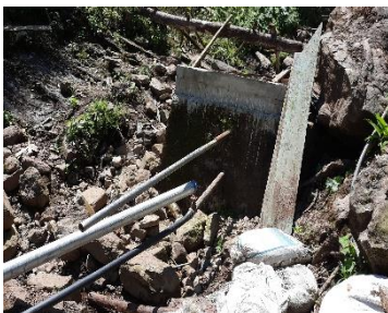
SUMINISTRO Y COLOCACIÓN DE TUBERIA EN LA CAJA DE CAPTACIÓN
