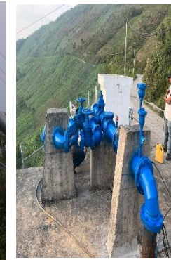
REHABILITACIÓN DE TREN DE DESCARGA.
