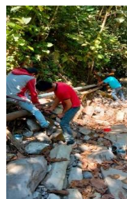
INSTALACION DE TUBERIA GALVANIZADA DE 4" PARA LA LÍNEA DE CONDUCCIÓN
