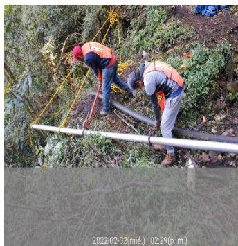
LIMPIA, TRAZO, NIVELACIÓN Y COLOCACIÓN DE TUBERÍA DE Fo.Go. DE 3" DE DIÁMETRO
