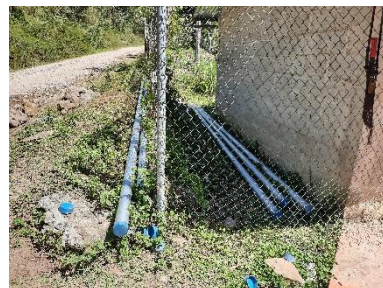
SUMINISTRO DE TUBERIA
