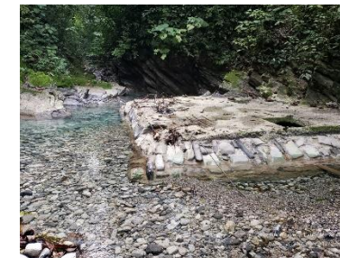
TRABAJOS PRELIMINARES DE LIMPIA Y TRAZO
