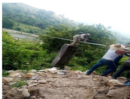
ETAPA DE PROCESO DE LA OBRA CON CRUZAMIENTO AÉREO DE LA LÍNEA DE CONDUCCIÓN EN EL RIO TECOLUTLA
