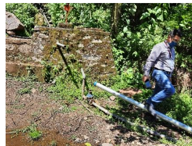
SUMINISTRO DE TUBERÍA EN EL LUGAR
