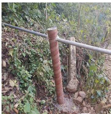
CONSTRUCCIÓN DE ATRAQUES PARA SOPORTAR LA TUBERÍA DE 2” DE DIÁMETRO
