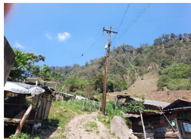
LLEGADA DE LA TUBERÍA GALVANIZADA AL LUGAR DE LOS TRABAJOS
