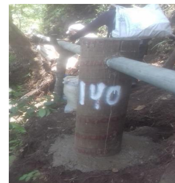
CONSTRUCCIÓN DE ATRAQUES EN LÍNEA DE CONDUCCIÓN
