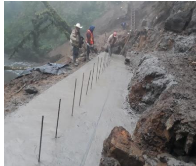
LIMPIA, TRAZO, NIVELACIÓN Y EXCAVACIÓN, PLANTILLA PARA LA COLOCACIÓN DEL MURO GAVIÓN
