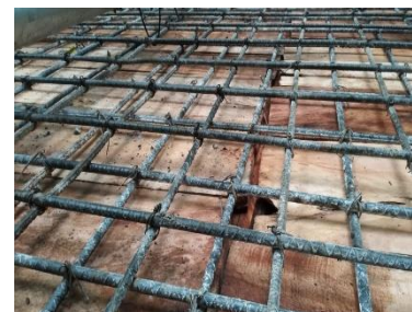
SUMINISTRO, HABILITADO Y COLOCACIÓN DE ACERO DE REFUERZO
