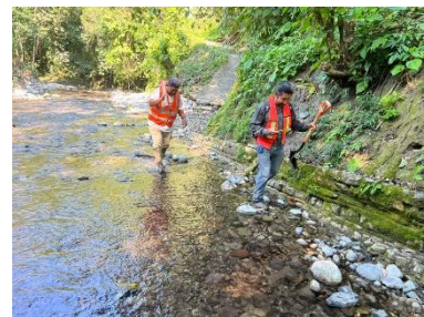
ACARREO DE MATERIAL HASTA EL SITIO DE LA CAJA DE CAPTACIÓN
