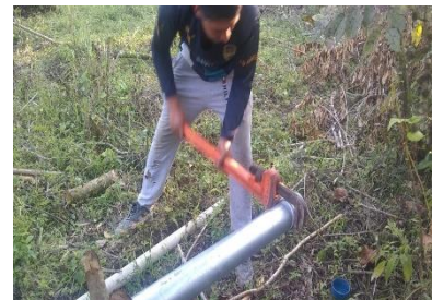
SUMINISTRO DE TUBERÍA E INSTALACIÓN
