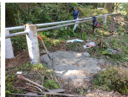
OBRA EN PROCESO CON LA REHABILITACIÓN DE LA LÍNEA DE CONDUCCIÓN Y LA CONSTRUCCIÓN DE ATRAQUES
