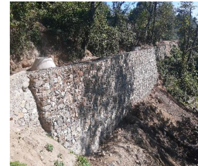
CONSTRUCCIÓN DE MURO GAVIÓN A BASE DE JAULAS DE MALLA Y PIEDRA BRASA
