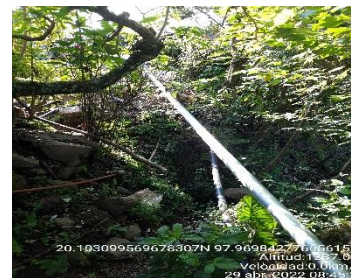
SUMINISTRO DE TUBERÍA GALVANIZADA Y COLOCACIÓN
