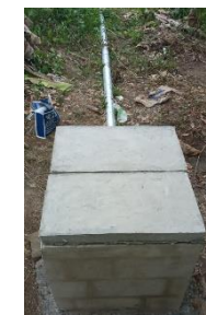
OBRA TERMINADA DE LA REHABILITACIÓN DE LÍNEA DE CONDUCCIÓN
