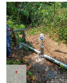
INSTALACIÓN DE VÁLVULA DE EXPULSIÓN DE AIRE
