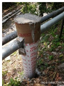
CONSTRUCCIÓN DE ATRAQUES DE CONCRETO
