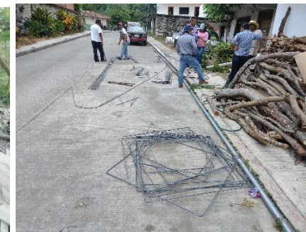
ETAPA DE PROCESO DE REHABILITACIÓN DE LÍNEA DE CONDUCCIÓN, HABILITADO DE ACERO PARA ZAPATAS Y ATRAQUE EN COLUMNAS Y ATRAQUES EN CADA MARGEN DE RIO PARA CRUZAR LA LÍNEA DE CONDUCCIÓN A TRAVÉS DEL RIO TECOLUTLA
