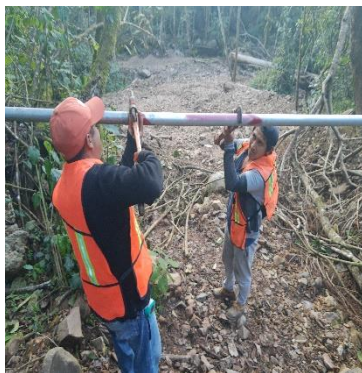
LIMPIA, TRAZO, NIVELACIÓN Y COLOCACIÓN DE TUBERÍA DE Fo.Go. DE 2” DE DIÁMETRO
