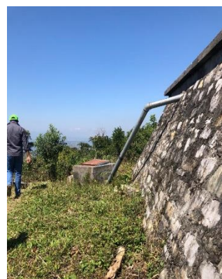
OBRA EN PROCESO CON EL SUMINISTRO DE TUBERÍA Y REHABILITACIÓN DE LA LÍNEA DE CONDUCCIÓN
