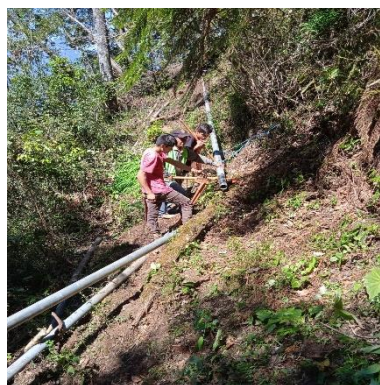
SUMINISTRO E INSTALACIÓN DE TUBERÍA DE 3" DE DIÁMETRO
