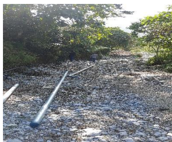
SUMINISTRO DE TUBERÍA PARA SU COLOCACIÓN
