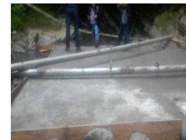
OBRA TERMINADA, CAJA DE CAPTACIÓN
