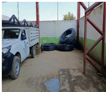
SUMINISTRO DE TUBERÍA DE ALTA DENSIDAD
