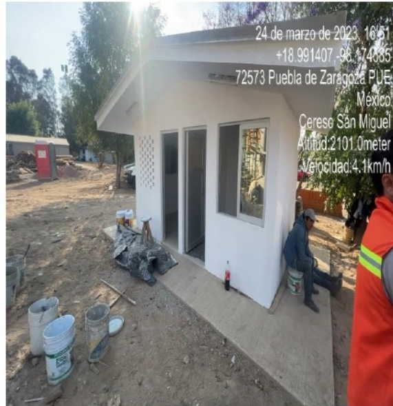
CUARTO DE MAQUINAS
