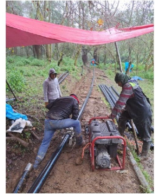
TERMOFUSION DE TUBERIA
