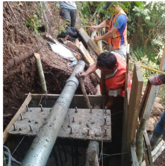
CIMBRADO Y PREPARACION DE BASE PARA ESTRUCTURA DE ACERO
