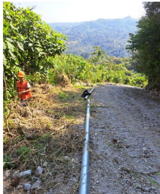
LIMPIEZA Y TENDIDO DE TUBERIA
