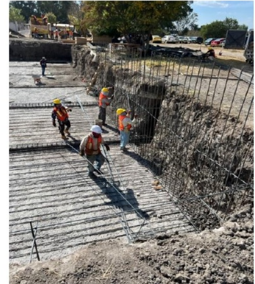
HABILITADO DE ACERO Y PLANTILLA EN CISTERNA
