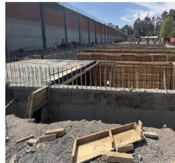
CISTERNA CON MUROS PERIMETRALES COLADOS Y CIMBRADO DE MUROS ROMPE OLAS
