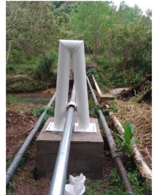
ESTRUCTURA PARA CRUCE AEREO
