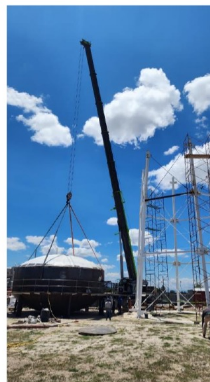
COLOCACIÓN DE DEPÓSITO DE TANQUE ELEVADO
