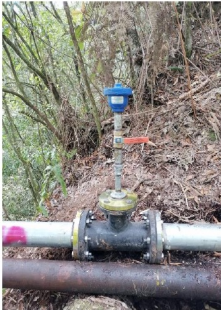
COLOCACION DE PIEZAS ESPECIALES V.E.A.
