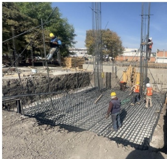
DESPLANTE DE COLUMNAS DE TANQUE ELEVADO
