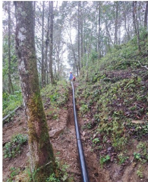
INSTALACION DE TUBERIA PAD
