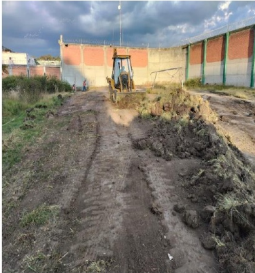
DESPALME DE CAPA VEGETAL PARA DESPLANTE DE ESTRUCTURAS
