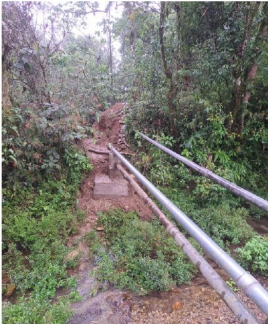
TENDIDO DE TUBERIA GALVANIZADA CRUCE AEREO
