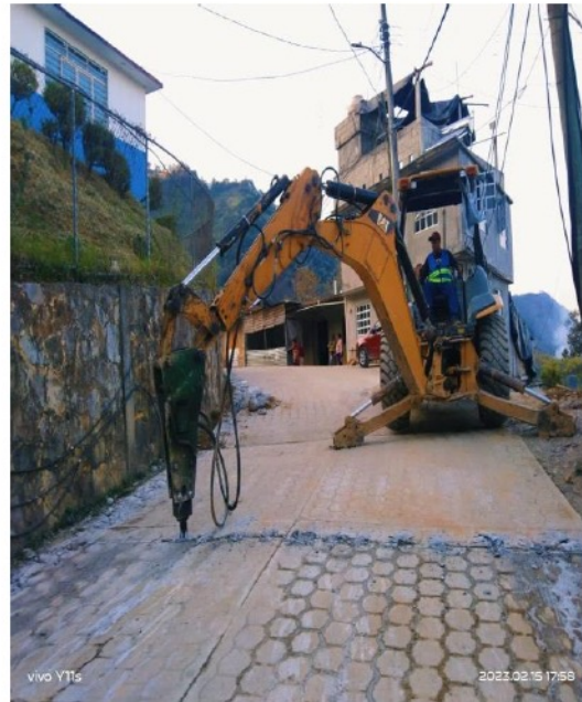
RUPTURA Y DEMOLICIÓN DE PAVIMENTO HIDRÁULICO
