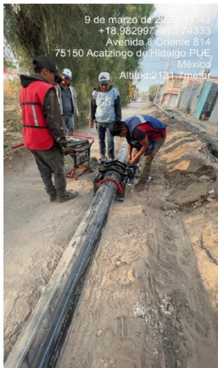
SUMINISTRO E INSTALACIÓN DE TUBERÍA DE POLIETILENO DE ALTA DENSIDAD
