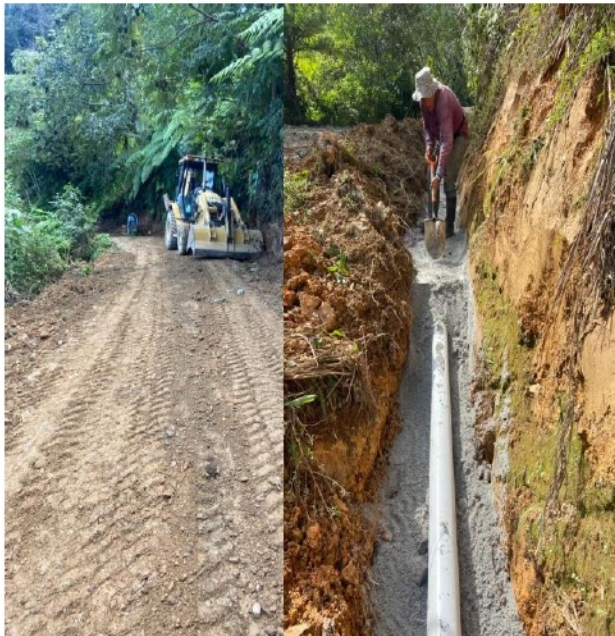
INSTALACIÓN DE TUBERÍA DE DISTRIBUCIÓN
