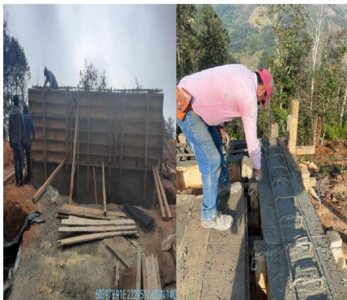
CONSTRUCCIÓN DE TANQUE DE REGULARIZACIÓN PRUEBAS DE CONCRETO
