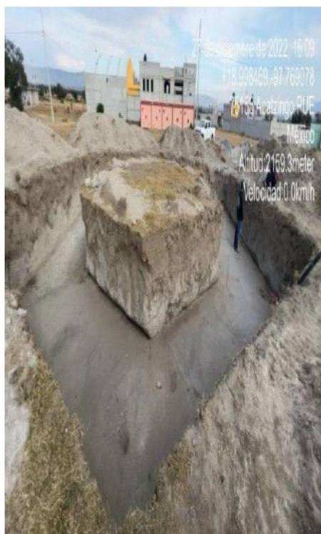
FABRICACIÓN Y COLADO DE CONCRETO
