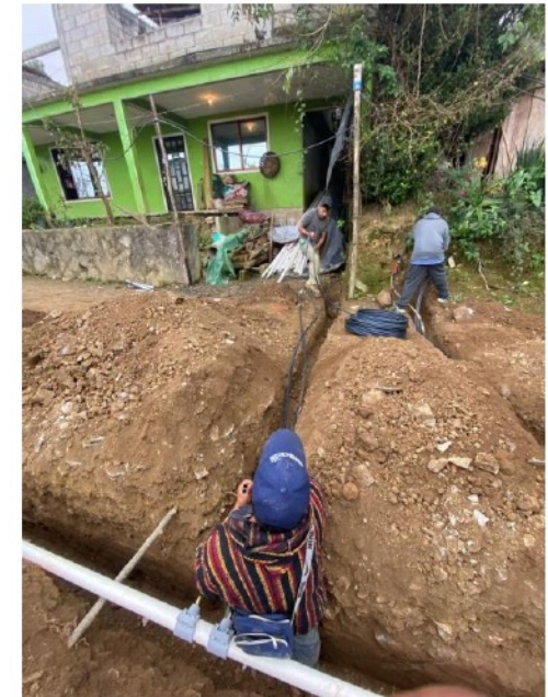
INSTALACIÓN DE TOMAS DOMICILIARIAS
