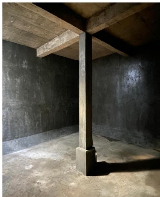
INTERIOR DEL TANQUE SUPERFICIAL DE CONCRETO ARMADO
