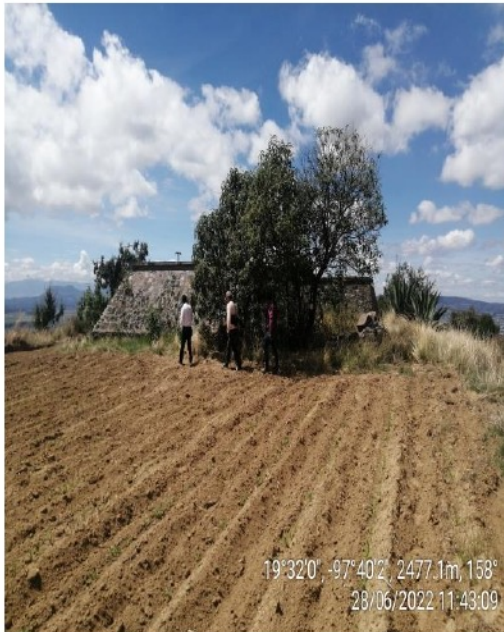
VERIFICACIÓN DE TANQUE DE ALMACENAMIENTO Y DISTRIBUCIÓN DE AGUA POTABLE
