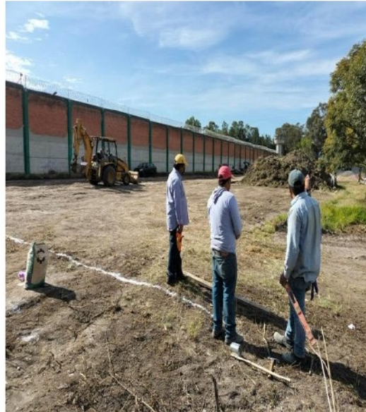
TRAZO EN SITIO DE LOS TRABAJOS
