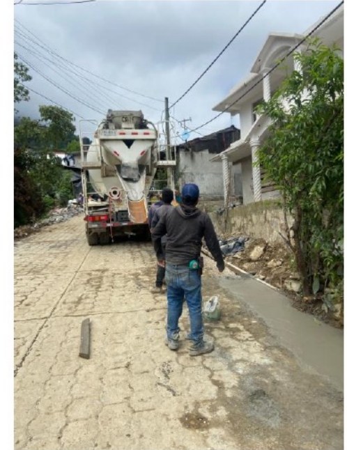
SUSTITUCIÓN DE PAVIMENTO HIDRÁULICO
