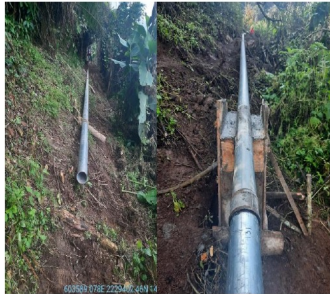
INSTALACIÓN DE TUBERÍA GALVANIZADA DE 4" DE DIÁMETRO LÍNEA DE CONDUCCIÓN Y ATRAQUE
