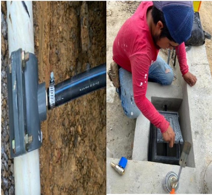
INSTALACIÓN DE CAJAS DE POLIETILENO Y DE TOMA DOMICILIARIA
