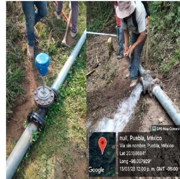
INSTALACIÓN DE VEA Y DE TEE GALVANIZADA DE 4"
