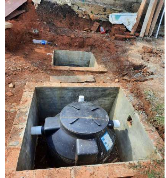
CONSTRUCCIÓN DEL REGISTRO DEL BIODIGESTOR
