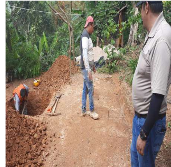
CONSTRUCCIÓN DE LA LOSA DE CIMENTACIÓN Y COLOCACIÓN DE MUROS DE TABIQUE
