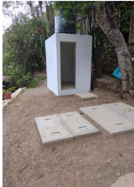
REGISTRO SANITARIO Y DE INSPECCIÓN TERMINADOS, DE BIODIGESTOR Y DE DEPOSITO DE LODOS CON TAPAS DE CONCRETO, PINTURA EN MUROS Y TINACO INSTALADO
