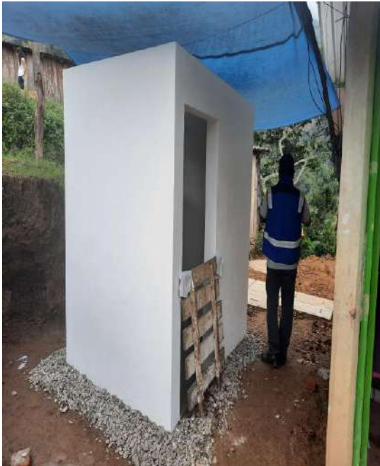
APLICACIÓN DE PINTURA EN MUROS
