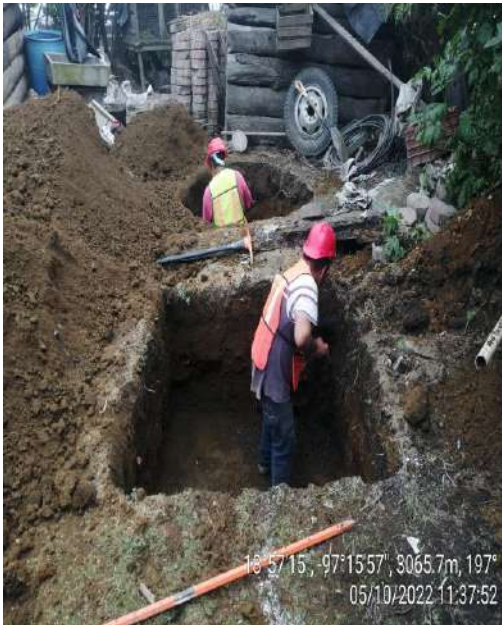
TRABAJOS DE EXCAVACIÓN EN REGISTROS DE BIODIGESTORES Y POZO DE ABSORCIÓN.
