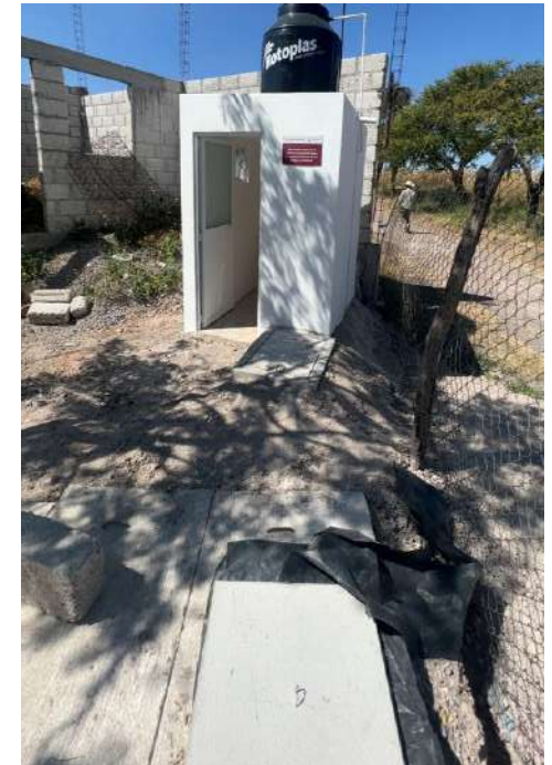
CASETA DE BAÑO Y TAPAS DE REGISTRO TERMINADAS
