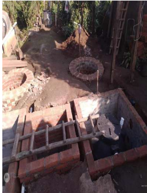
EXCAVACIONES, CONSTRUCCIÓN Y COLOCACIÓN DE REGISTROS DE BIODIGESTORES Y LODOS
