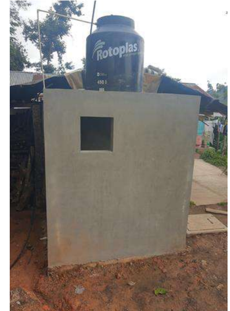
CONSTRUCCIÓN DE CASETA, REPELLADO DE MUROS Y EMBOQUILLADO DE PUERTA Y VENTANA.
