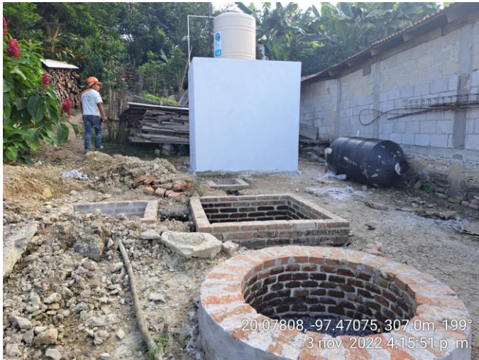
REGISTROS DE LODOS, BIODIGESTOR Y POZO DE ABSORCIÓN
