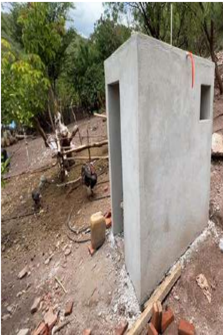
CASETA DE BAÑO EN OBRA GRIS
