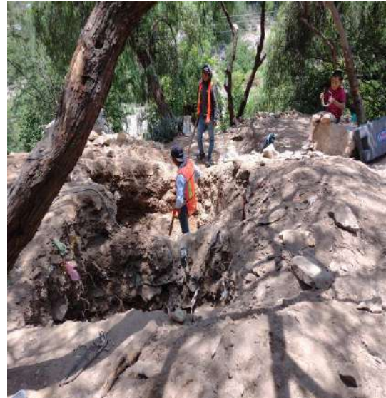
ACTIVIDAD DE EXCAVACIÓN A MANO Y EN ROCA FIJA PARA DESPLANTE DE ESTRUCTURAS
