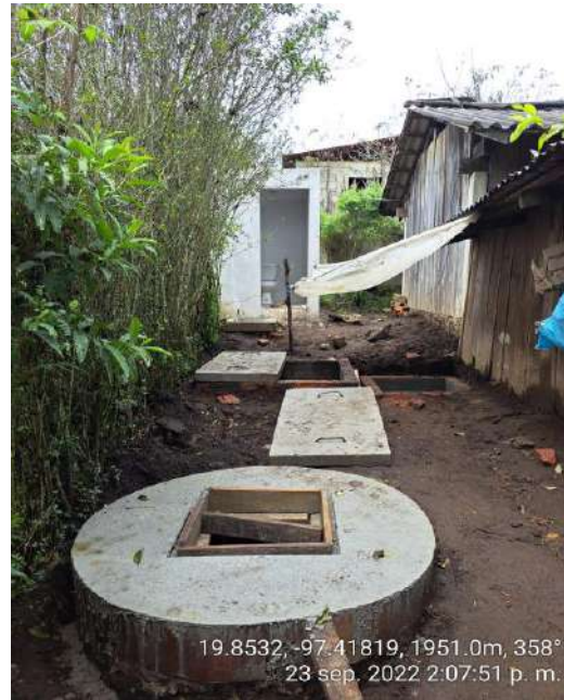
CONSTRUCCIÓN DE MÓDULO SANITARIO Y REGISTROS
