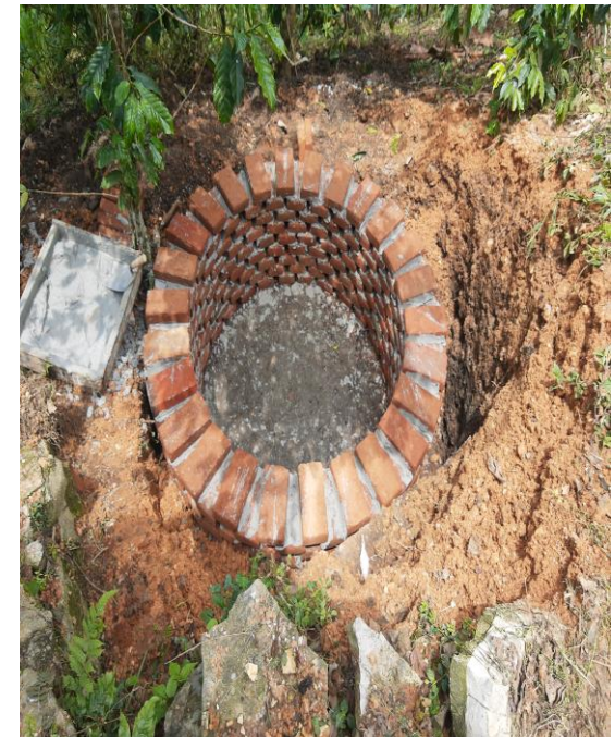
CONSTRUCCIÓN DE POZO DE ABSORCIÓN Y FILTRO DE GRAVA
