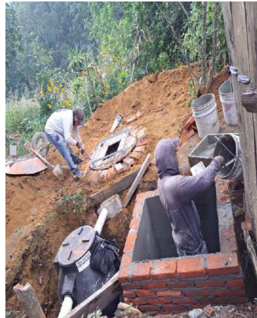
CONSTRUCCION DE REGISTRO DE INSPECCION Y ALOJAMIENTO DE BIODIGESTOR
