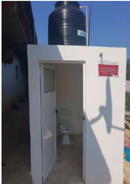
CONSTRUCCIÓN DE CASETA TERMINADA
