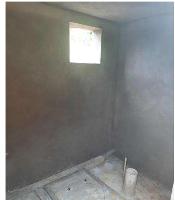
REPELLADO EN MUROS DE TABIQUE ROJO RECOCIDO
