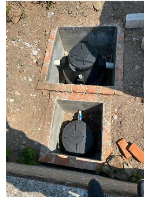
INSTALACIÓN DE BIODIGESTOR Y REGISTRO DE LADOS
