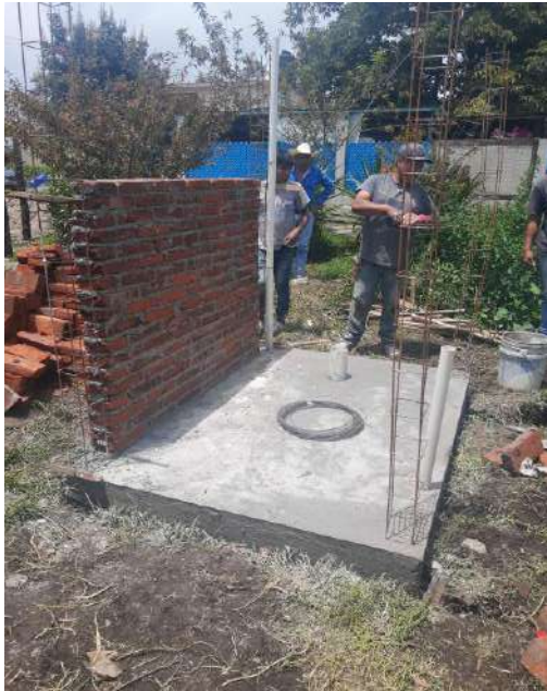
CONSTRUCCIÓN DE LOSA DE PISO E INICIO DE MUROS PARA CASETAS
