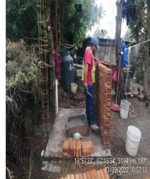
TRABAJOS DE CONSTRUCCIÓN DE MUROS DE TABIQUE EN BAÑO ECOLÓGICO.
