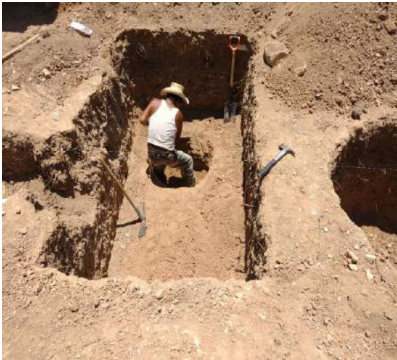
ACTIVIDADES PRELIMINARES DE LIMPIEZA Y TRAZO Y EXCAVACIÓN PARA DESPLANTE DE ESTRUCTURAS
