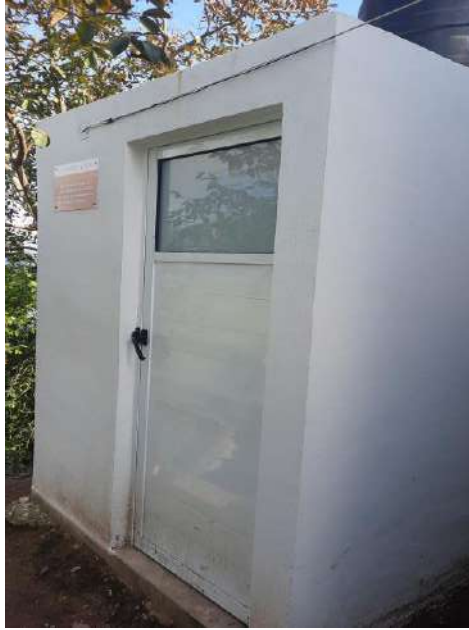
ACCIÓN TERMINADA CON SU PUERTA DE ALUMINIO Y PLACA DE IDENTIFICACIÓN
