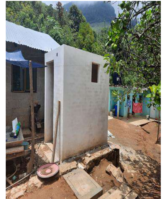
REPELLADO EN LA ACCIÓN DE TABIQUE ROJO RECOCIDO
