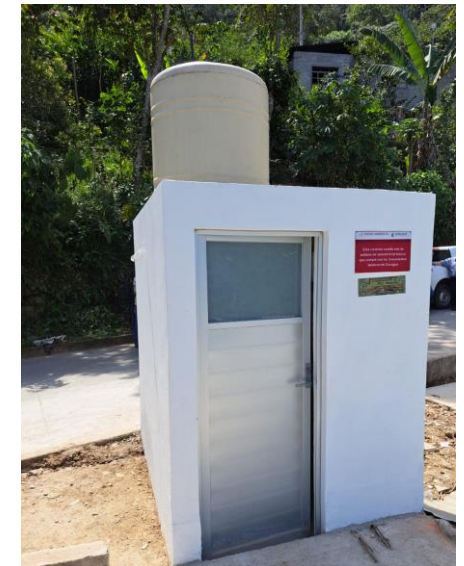
MODULO SANITARIO TERMINADO
