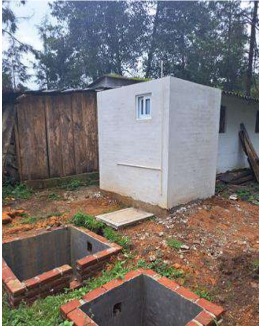
CONSTRUCCIÓN DE REGISTROS PARA BIODIGESTOR Y LODOS
