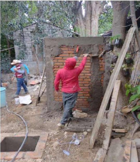
PROCESO DE REPELLADO EN CASETA DE BAÑO
