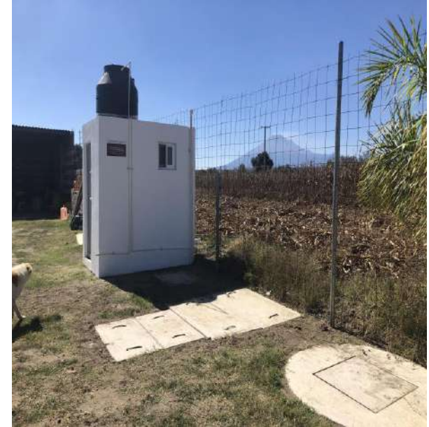
CASETA DE BAÑO TERMINADA CON CANCELERÍA DE ALUMINIO EN PUERTA Y VENTANA
