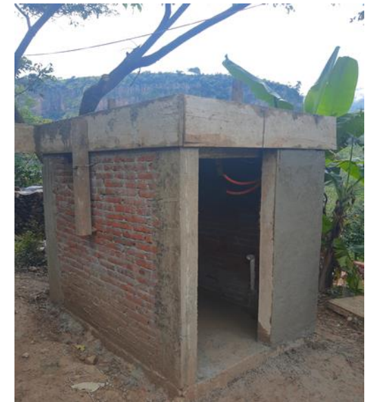
CONSTRUCCIÓN DE CASETA, REPELLADO DE MUROS Y EMBOQUILLADO DE PUERTA Y VENTANA.
