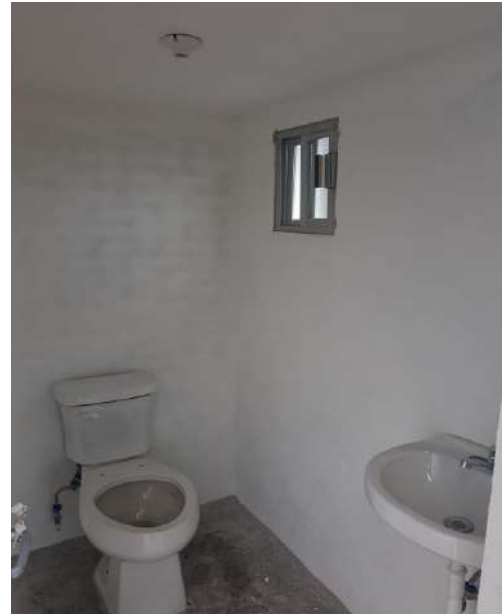
COLOCACIÓN DE MUEBLES SANITARIOS
