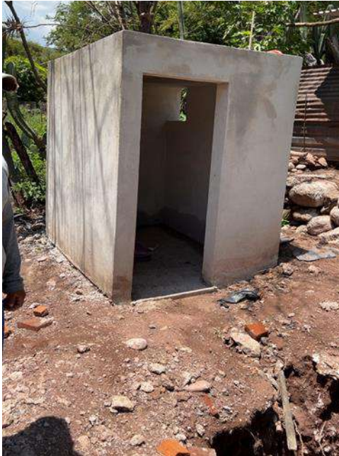
CASETA DE BAÑO EN OBRA GRIS
