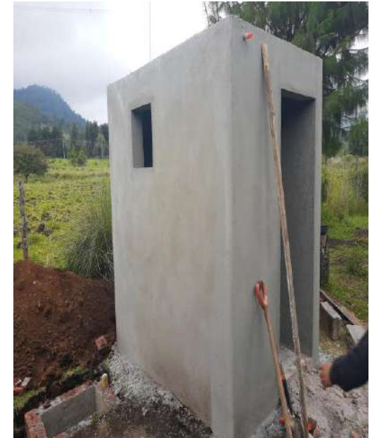
CONSTRUCCIÓN DE CASETA, REPELLADO DE MUROS Y EMBOQUILLADO DE PUERTA Y VENTANA.
