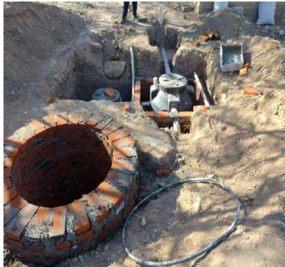
PROCESO DE LA OBRA CONSTRUCCIÓN DE POZO DE ABSORCIÓN, REGISTROS DE INSPECCIÓN PARA BIODIGESTOR Y DEPOSITO DE LODOS
