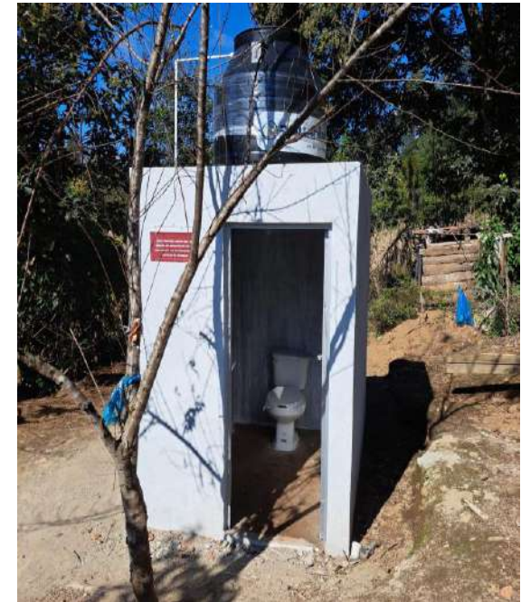
MODULO SANITARIO TERMINADO
