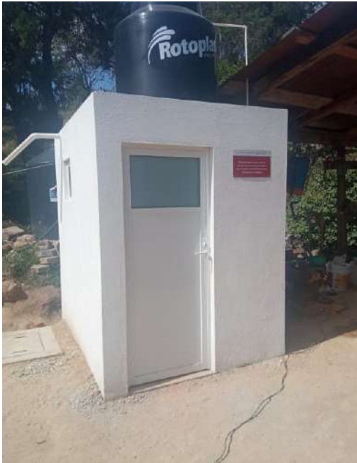
TRABAJOS TERMINADOS DE BAÑO, CANCELERÍA Y TANQUE DE 450 LITROS.
