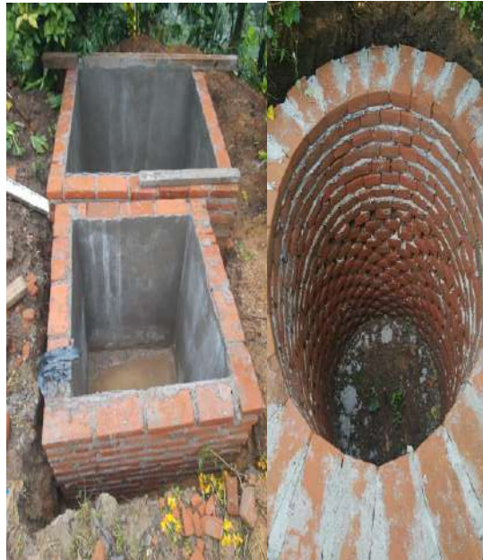
CONSTRUCCIÓN DE REGISTRO PARA EL BIODIGESTOR, LODOS Y POZO DE ABSORCIÓN
