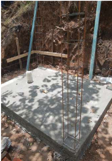
CONSTRUCCIÓN DE LOSA DE PISO E INICIO DE MUROS PARA DESPLANTE DE MURO DE TABIQUE
