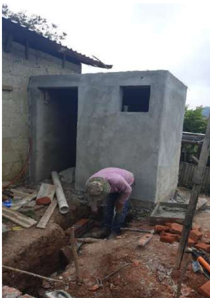
REPELLADO EN MUROS DE TABIQUE ROJO RECOCIDO
