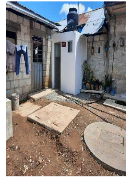
ACCIÓN TERMINADA CON REGISTROS TERMINADOS CON SUS TAPAS DE CONCRETO
