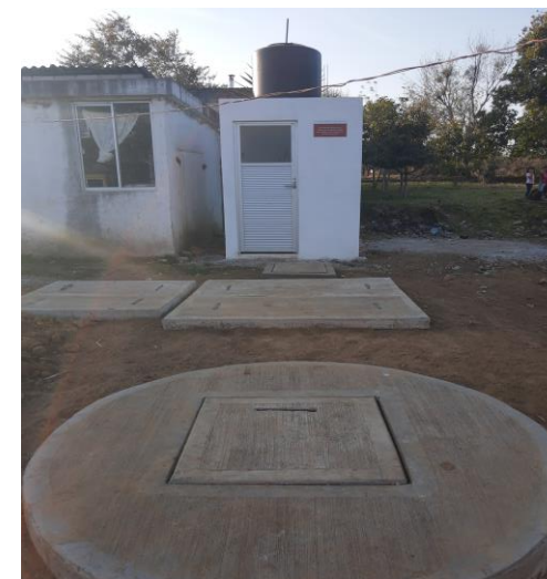
CONSTRUCCIÓN DE REGISTRO DE INSPECCIÓN, DE BIODIGESTOR, DE LODOS Y POZO DE ABSORCIÓN TERMINADOS
