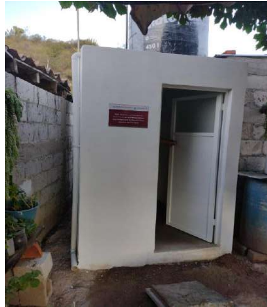
CASETA DE BAÑO TERMINADA, CON BAJADA DE AGUA PLUVIAL, PLACA DE IDENTIFICACIÓN Y CANCELERIA DE ALUMINO
