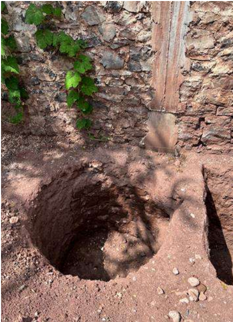
EXCAVACIÓN EN MATERIAL COMÚN
