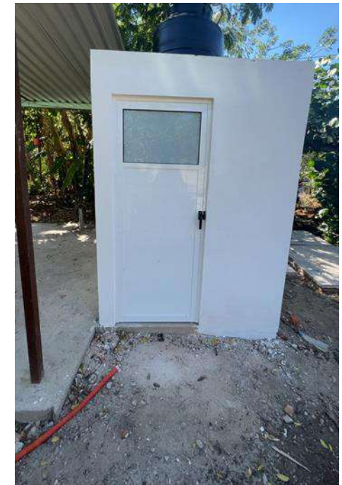
CASETA DE BAÑO TERMINADA
