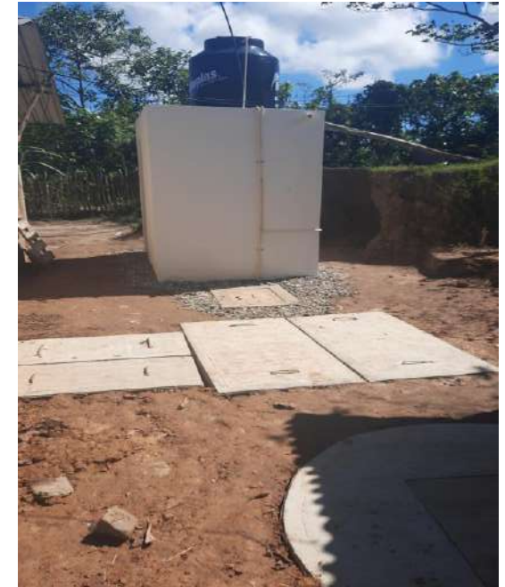
ACCIÓN TERMINADA CON TANQUE PARA AGUA Y REGISTROS
