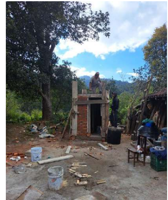
CONSTRUCCION DE CASETA MODULO SANITARIO
