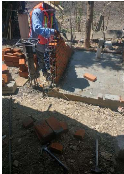
DESPLANTE DE MURO DE TABIQUE PARA CASETA
