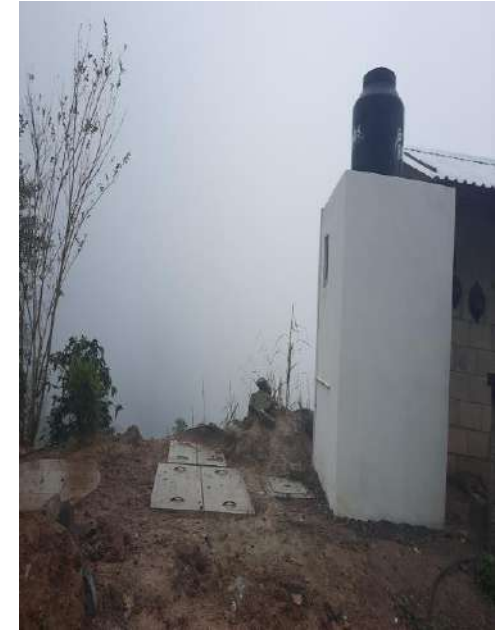
ACCIÓN TERMINADA CON REGISTROS TERMINADOS CON SUS TAPAS DE CONCRETO
