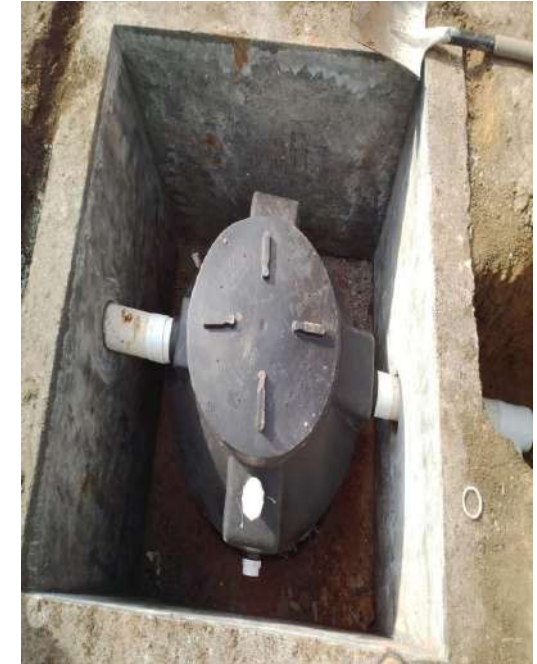
SUMINISTRO Y COLOCACIÓN DE BIODIGESTOR
