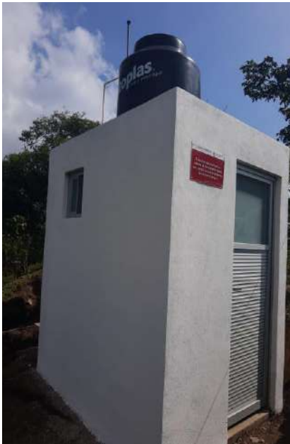
CONSTRUCCIÓN DE CASETA TERMINADA
