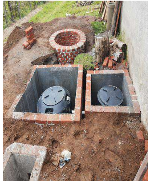
CONSTRUCCIÓN DE REGISTRO DE INSPECCIÓN, BIODIGESTOR, LODOS Y POZO DE ABSORCIÓN
