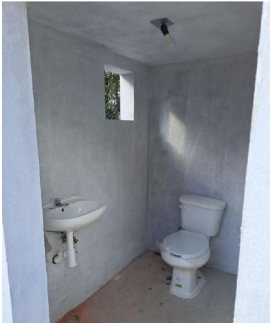
COLOCACIÓN DE MUEBLES SANITARIOS
