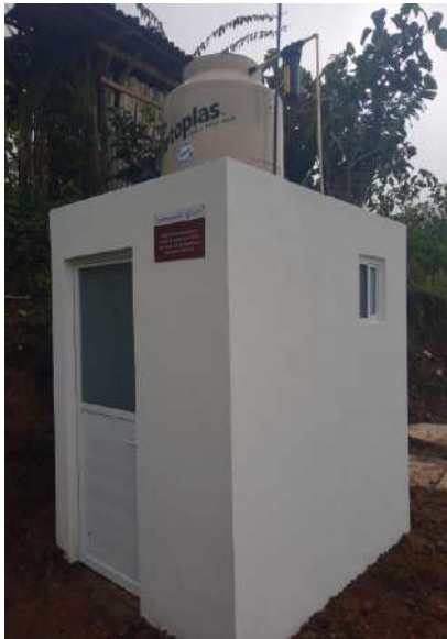
CONSTRUCCIÓN DE CASETA TERMINADA
