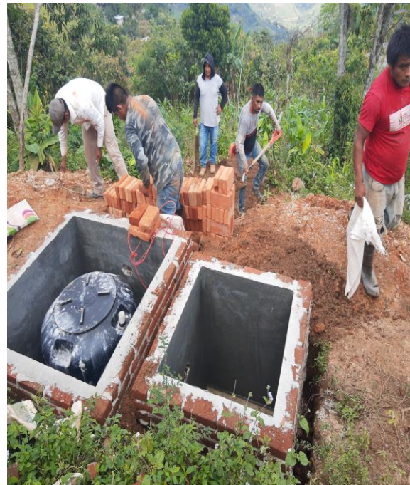
CONSTRUCCIÓN DE REGISTRO DEL BIODIGESTOR Y LODOS APLANADO DE MUROS Y PULIDO
