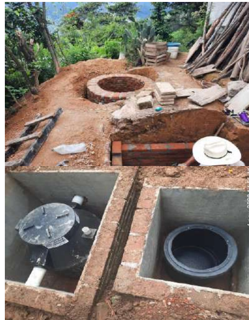
EXCAVACIÓN Y CONSTRUCCIÓN DE REGISTROS DE BIODIGESTOR Y POZO DE ABSORCIÓN
