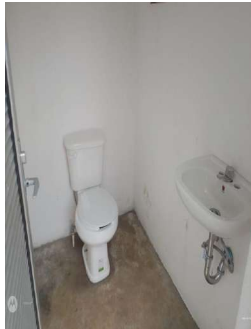
SUMINISTRO Y COLOCACIÓN DE MUEBLES SANITARIOS
