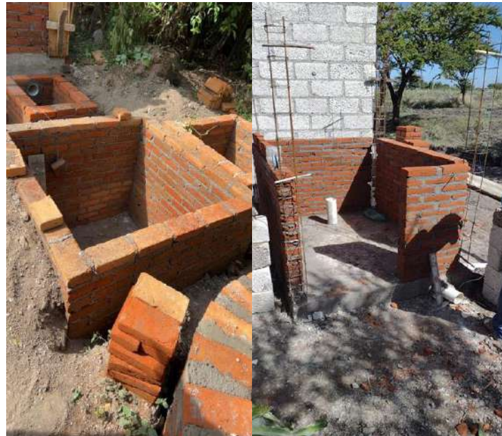
CONSTRUCCIÓN DE MURO DE TABIQUE DE CASETA Y REGISTROS
