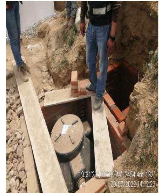
SUMINÍSTRO Y COLOCACIÓN DE BIODIGESTOR EN REGISTRO DE TABIQUE.
