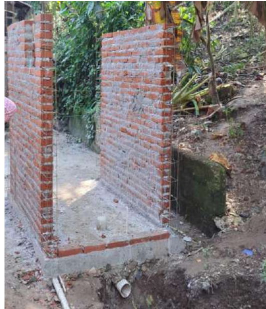
CONSTRUCCIÓN DE MÓDULO SANITARIO
