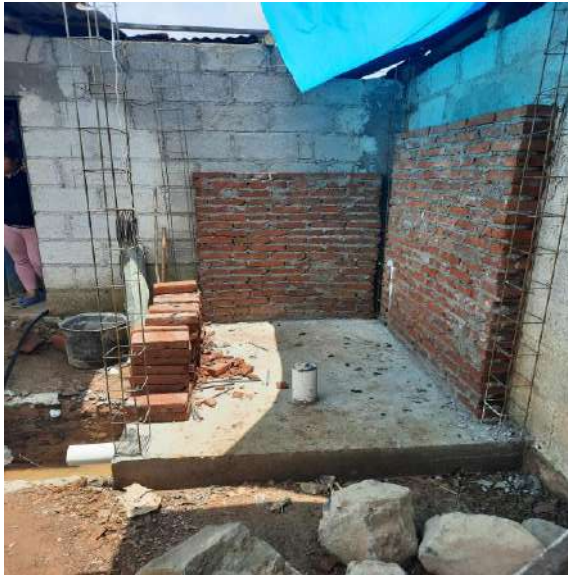
EXCAVACIÓN PARA LOS REGISTROS DE BIODIGESTOR, LODOS Y POZO DE ABSORCIÓN
