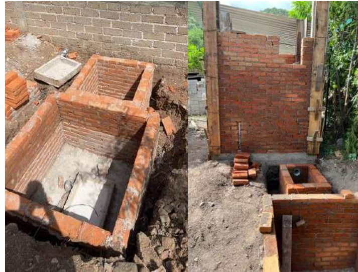
CONSTRUCCIÓN DE REGISTROS Y MUROS DE TABIQUE
