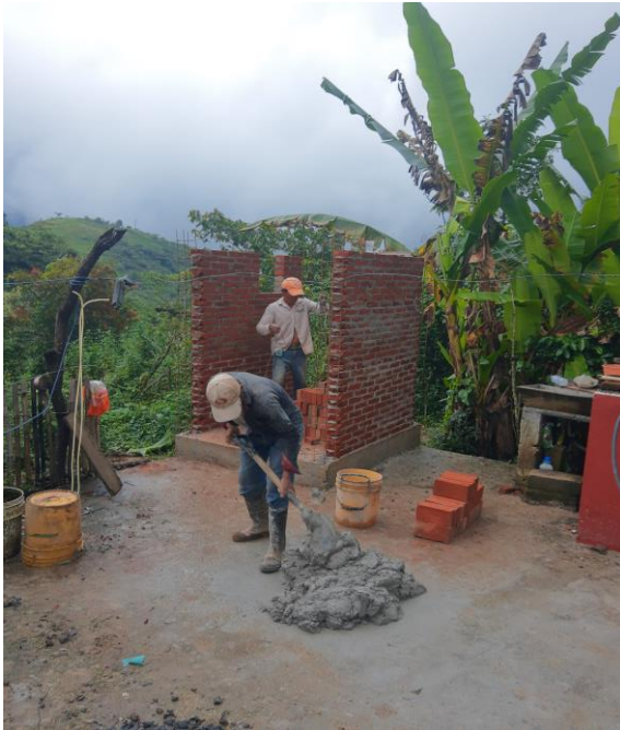
CONSTRUCCIÓN DE CASETA Y COLADO DE LOSA DE PISO, CONSTRUCCIÓN DE MURO DE TABIQUE
