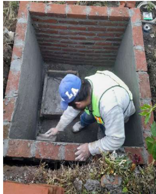
TRABAJOS DE CONSTRUCCIÓN DE MUROS DE TABIQUE PARA REGISTRO DE LODOS.
