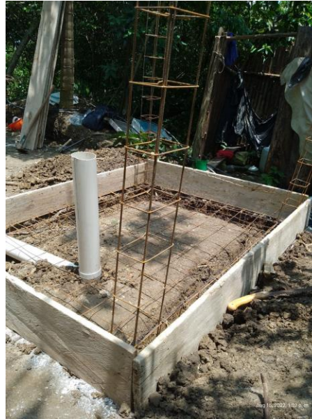
CONSTRUCCIÓN DE LOSA DE PISO E INICIO DE MUROS PARA DESPLANTE DE MURO DE TABIQUE
