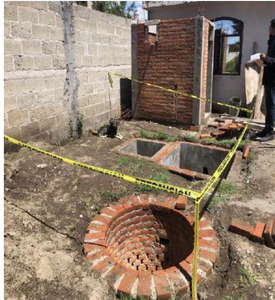
SISTEMA DE TRATAMIENTO, CONSTRUCCIÓN DE REGISTROS PARA REGISTRO DE LODOS, BIODIGESTOR Y POZO DE ABSORCIÓN
