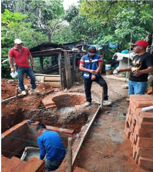
EXCAVACIÓN PARA LOS REGISTROS DE SANITARIO BIODIGESTOR, DE LODOS Y ABSORCIÓN
