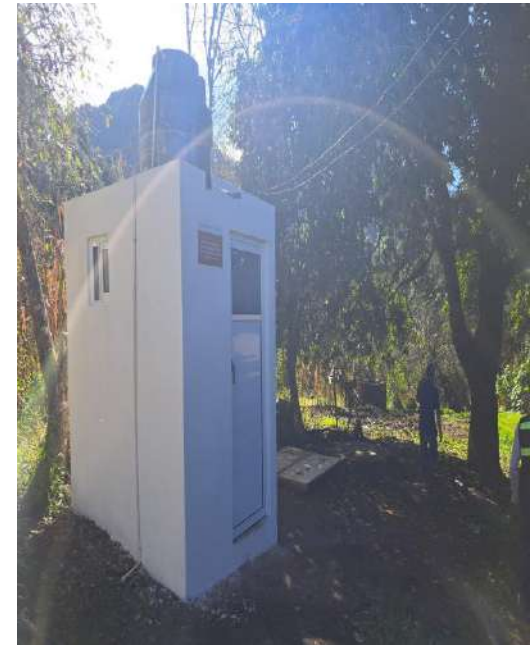
MÓDULO SANITARIO TERMINADO
