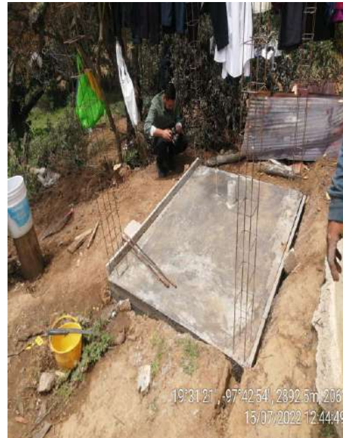
TRABAJOS DE LOSA DE PISO Y ANCLADO DE CASTILLOS
