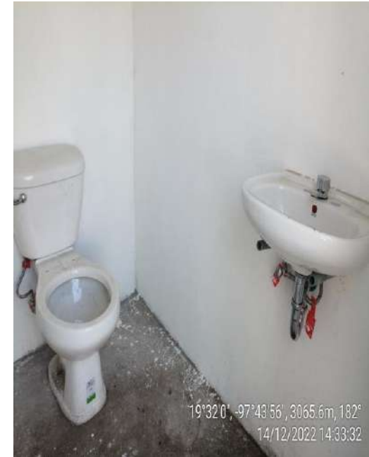
SUMINISTRO Y COLOCACIÓN DE MUEBLES SANITARIOS
