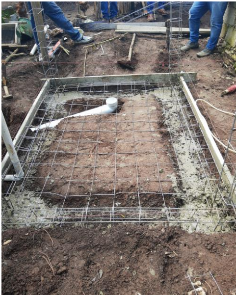
COLADO DE DADOS PARA DESPLANTE DE CADENAS PARA COLADO DE PISO
