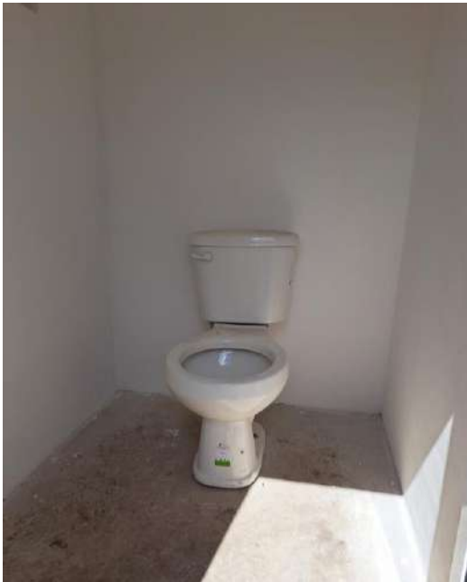
INSTALACIÓN DE MUEBLES SANITARIOS
