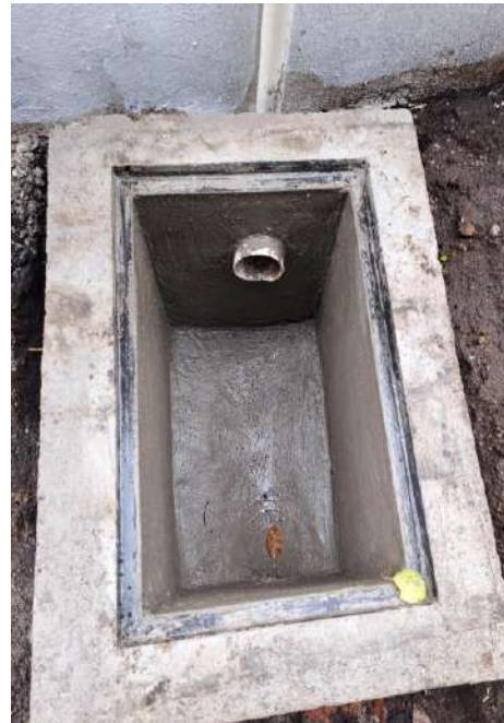
CONSTRUCCIÓN DE REGISTRO DE INSPECCIÓN
