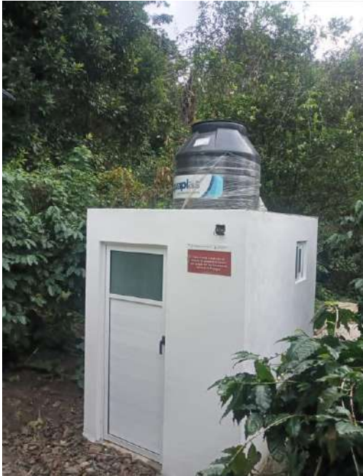
TRABAJOS DE BAÑO TERMINADO
