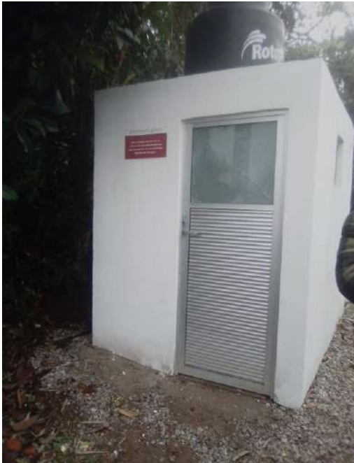
TRABAJOS DE BAÑO TERMINADO INCLUYENDO CANCELERÍA
