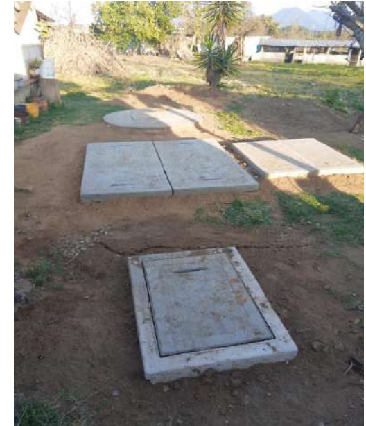
CONSTRUCCIÓN DE REGISTRO DE INSPECCIÓN, DE BIODIGESTOR, DE LODOS Y POZO DE ABSORCIÓN TERMINADOS
