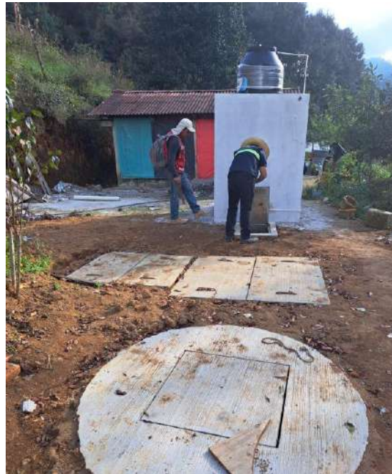
REGISTROS DE LODOS, BIODIGESTOR Y POZO DE ABSORCION
