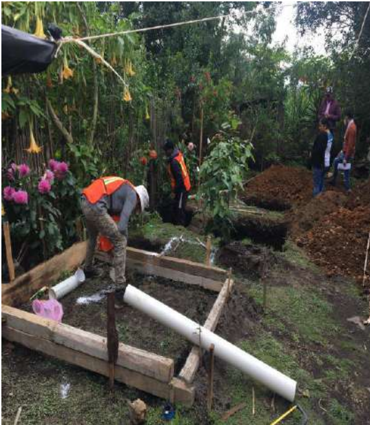
LIMPIA TRAZO Y DESPLANTE DE MÓDULO SANITARIO
