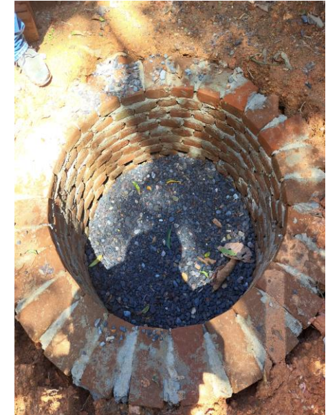
CONSTRUCCION POZO DE ABSORCION PARA MODULO SANITARIO
