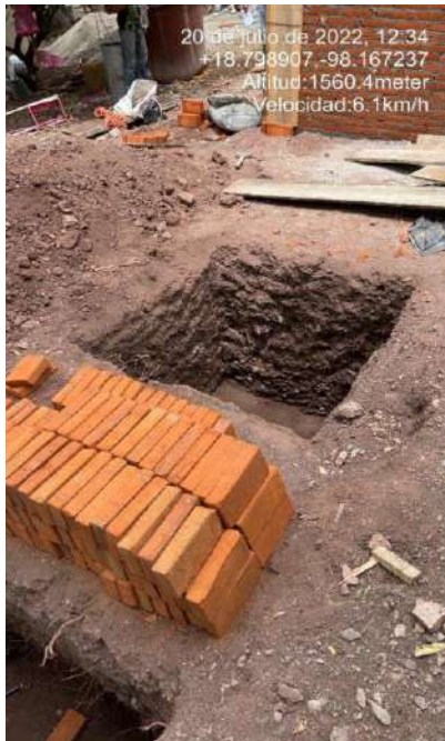
EXCAVACIÓN DE REGISTROS
