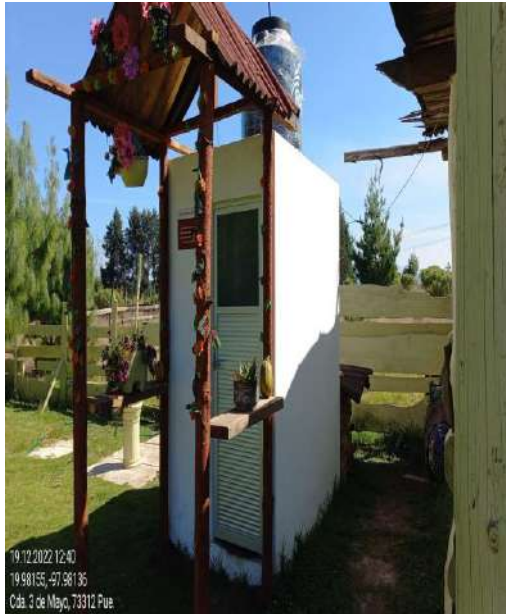
CONSTRUCCIÓN DE CASETA TERMINADA
