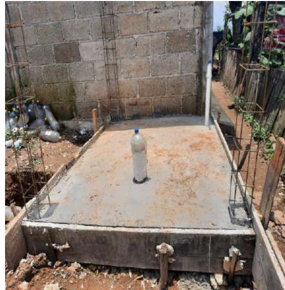
CONSTRUCCIÓN DE LOSA DE CIMENTACIÓN
