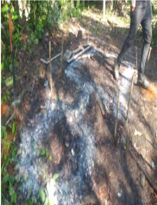
TRABAJOS DE TRAZO EN ÁREAS PROPUESTAS POR BENEFICIARIOS.
