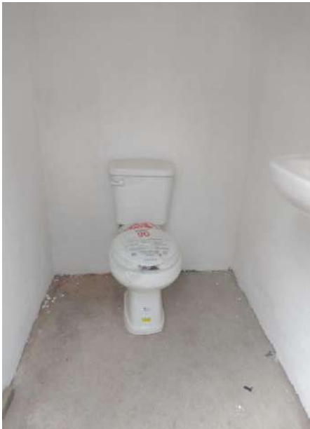
CASETA DE BAÑO TERMINADA CON MUEBLES SANITARIOS
