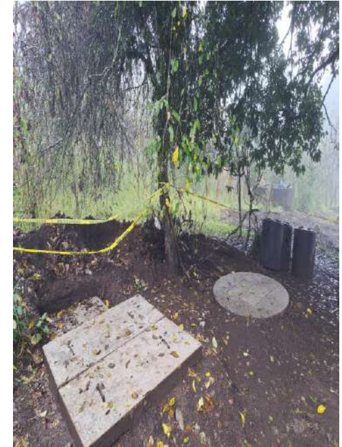
REGISTROS TERMINADOS DE BIODIGESTOR, LODOS Y ABSORSIÓN, CON TAPAS
