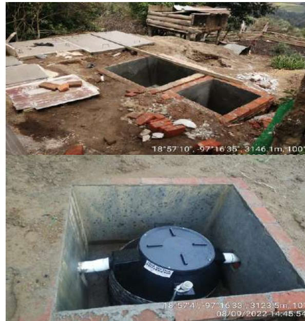
EXCAVACIONES, CONSTRUCCIÓN Y COLOCACIÓN DE REGISTROS DE BIODIGESTORES Y LODOS
