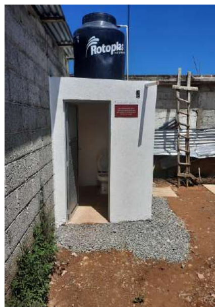
ACCIÓN TERMINADA CON SUS MUEBLES DE BAÑO
