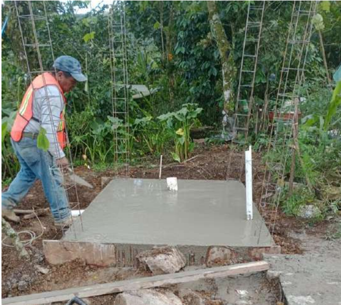
CONSTRUCCIÓN DE LOSA DE PISO PARA DESPLANTE DE MUROS DE TABIQUE E INSTALACIONES SANITARIAS
