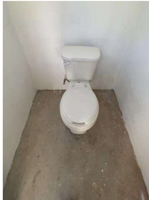
W.C. INSTALADO EN CASETA
