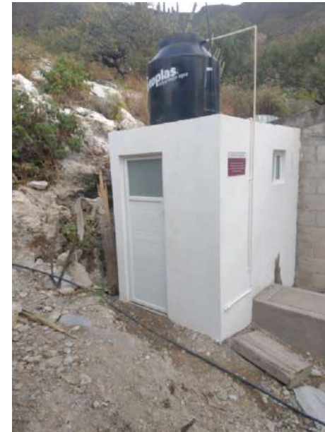
CASETA DE BAÑO TERMINADA CON CANCELERÍA DE ALUMINIO EN PUERTA Y VENTANA
