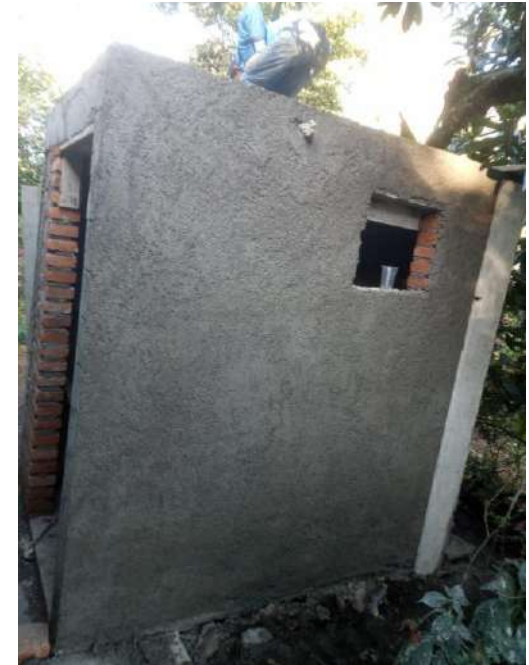
CONSTRUCCIÓN Y REPELLADO DE BAÑO ECOLÓGICO
