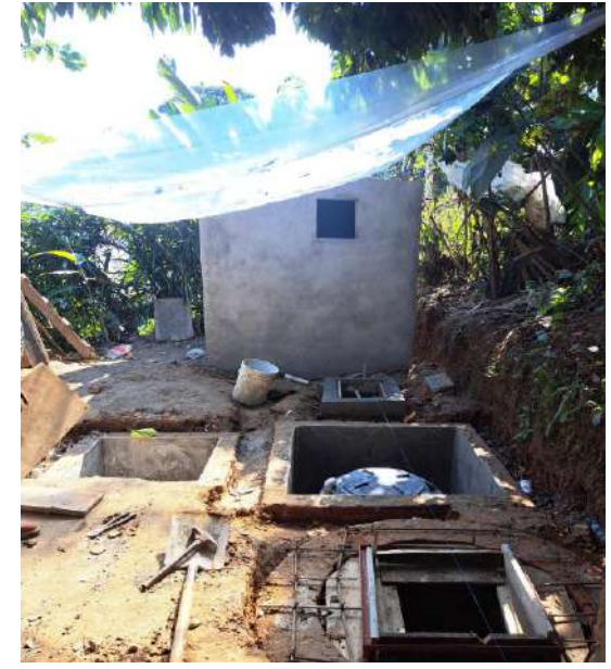
CONSTRUCCIÓN DE MÓDULO SANITARIO REGISTROS DE BIODIGESTOR, FOSA DE LODOS Y ABSORSIÓN.
