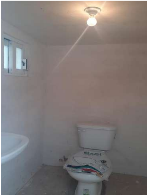
COLOCACIÓN DE MUEBLES W.C. LAVABO Y SU INSTALACIÓN ELÉCTRICA
