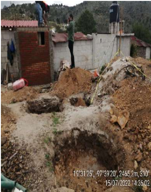
TRABAJOS DE CONSTRUCCIÓN DE BAÑO Y EXCAVACIONES EN REGISTROS SANITARIOS.
