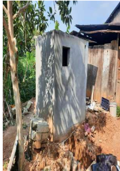
CONSTRUCCIÓN DE TAPAS DE CONCRETO PARA LOS REGISTROS
