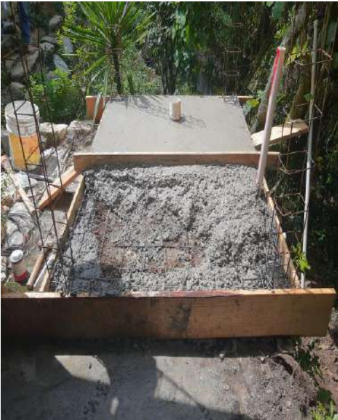
CONSTRUCCIÓN DE LOSA DE PISO PARA DESPLANTE DE MUROS DE TABIQUE E INSTALACIONES SANITARIAS
