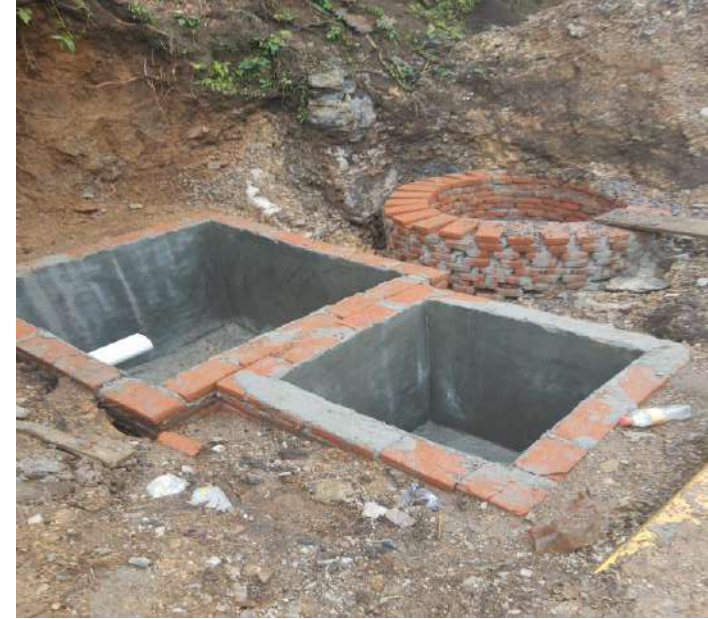
CONSTRUCCIÓN DE REGISTRO DE INSPECCIÓN PARA EL BIODIGESTOR, LODOS Y POZO DE ABSORCIÓN
