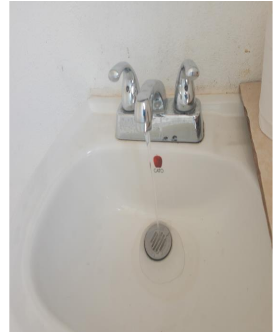
COLOCACIÓN DE MUEBLES SANITARIOS, FUNCIONANDO
