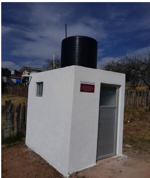
CONSTRUCCIÓN DE CASETA TERMINADA
