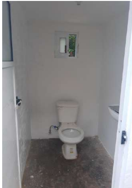
COLOCACIÓN DE MUEBLES SANITARIOS
