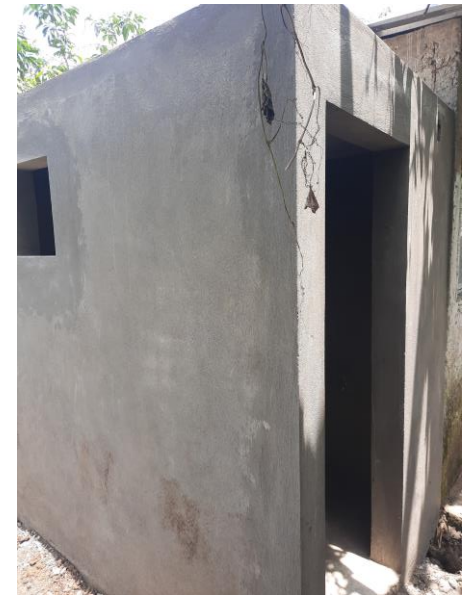
REPELLADO EN LA ACCÓN DE TABIQUE ROJO RECOCIDO
