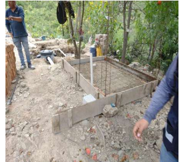
HABILITADO Y COLOCACIÓN DE MALLA ELECTROSOLDADA, ARMEX EN CASTILLOS, CIMBRA EN CIMENTACIONES, INSTALACIONES DE BIODIGESTOR, DEPOSITO DE LODOS Y TUBERÍA SANITARIA
