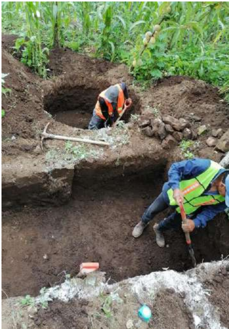
LIMPIA TRAZO Y EXCAVACIÓN
