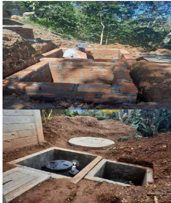
CONSTRUCCIÓN DE LOS REGISTROS BIODIGESTOR, DE LODOS Y ABSORCIÓN
