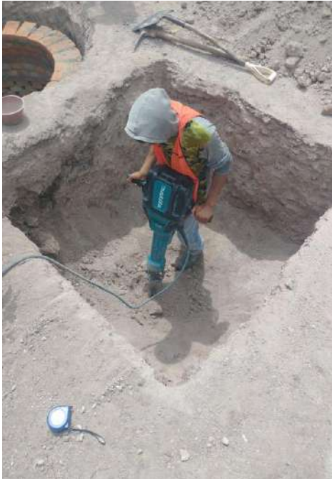
EXCAVACIÓN EN ROCA
