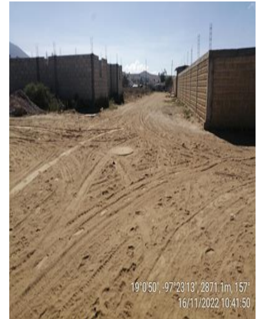
TRABAJOS TERMINADOS POZOS DE VISITA Y REGISTROS SANITARIOS
