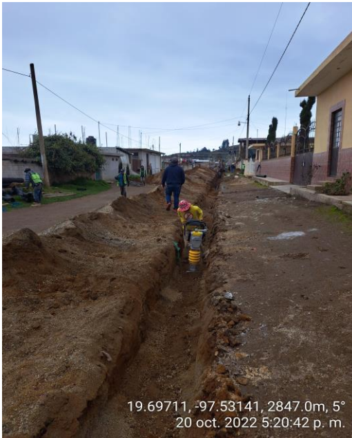
COMPACTACION CON MATERIAL DE BANCO EN ZANJA
