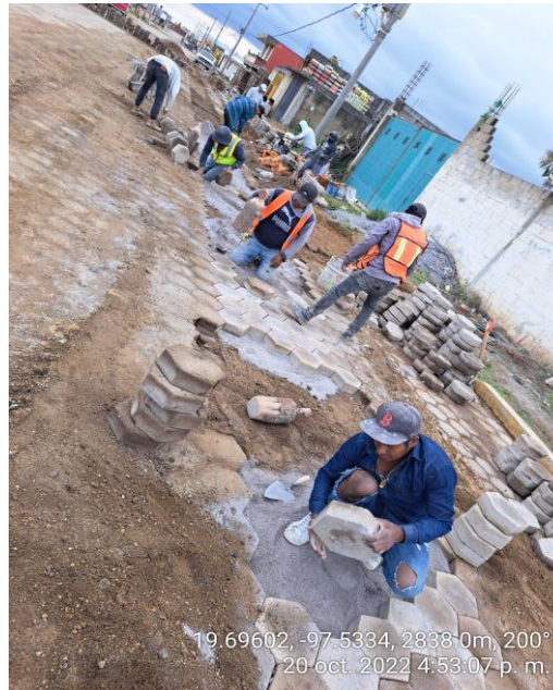
REPARACIÓN DE ADOQUIN
