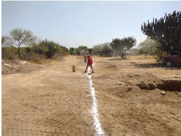
ACTIVIDADES DE INICIO CON LIMPIA, TRAZO EN EL ÁREA DE TRABAJO
