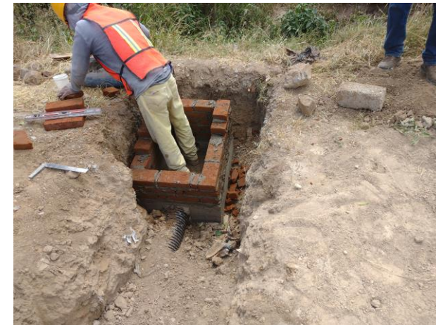
PROCESO DE LA OBRA CON LA CONSTRUCCIÓN DE LOS REGISTROS PARA LAS VIVIENDAS
