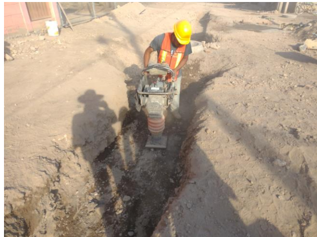
PROCESO DE LA OBRA CON EL ACOSTILLAMIENTO Y RELLENO DE LA TUBERÍA DE LA RED DE DRENAJE
