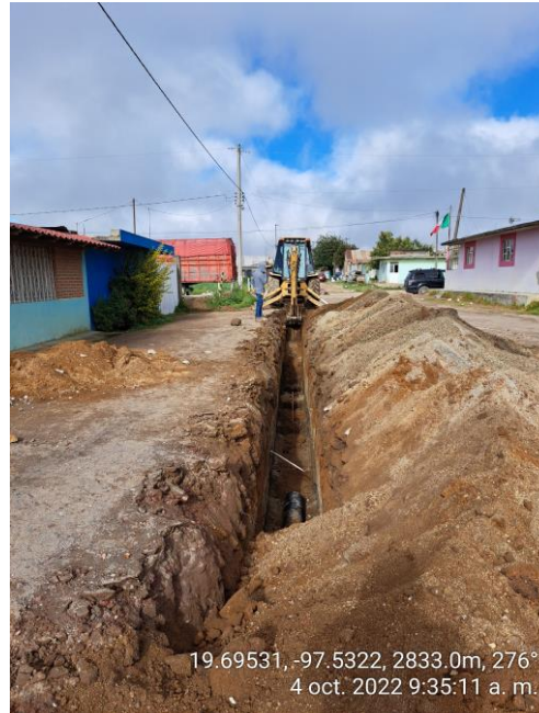
EXCAVACIÓN PARA ALOJAR TUBERIA PAD DE ALCANTARILLADO SANITARIO
