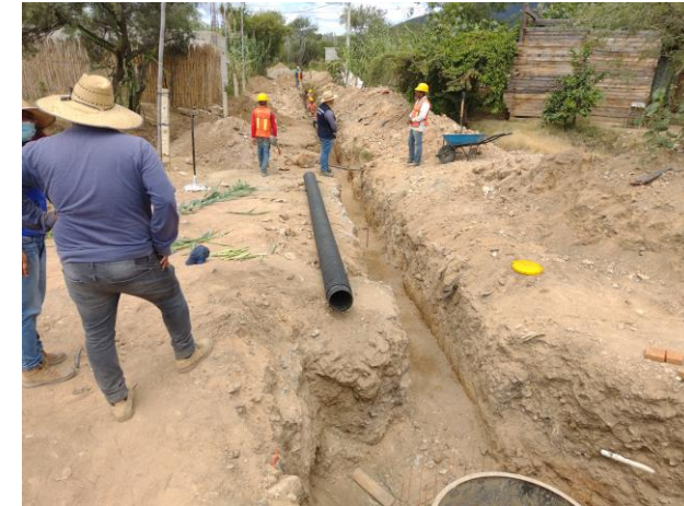
PROCESO DE OBRA CON LA INSTALACIÓN DE TUBERÍA DE POLIETILENO DE 8 PULGADAS DE DIÁMETRO PARA LA RED DE DRENAJE
