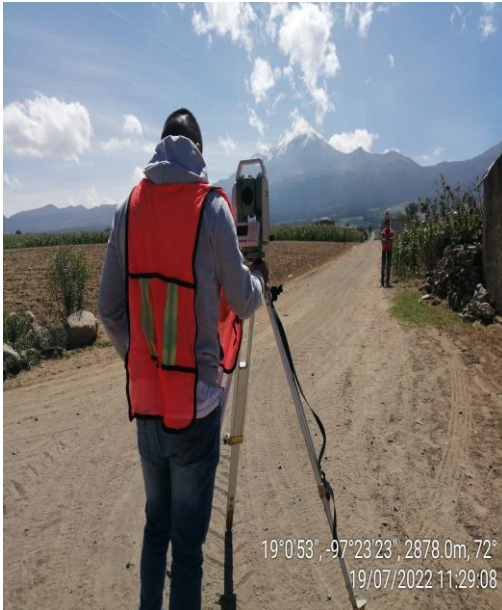
TRABAJOS DE TOPOGRAFÍA, VERIFICANDO LAS PENDIENTES NECESARIAS PARA LA CORRECTA EJECUCIÓN DE LOS TRABAJOS.
