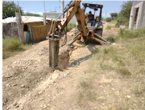
INICIO DE OBRA CON EXCAVACIÓN DE ZANJA EN MATERIAL DE ROCA
