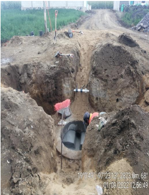
TRABAJOS DE CONSTRUCCIÓN DE POZOS DE VISITA DIFERENTES PROFUNDIDADES.
