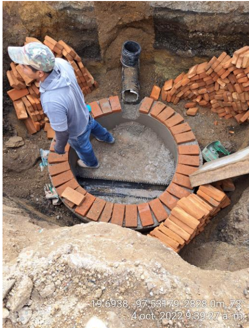
CONSTRUCCIÓN DE POZO DE VISITA
