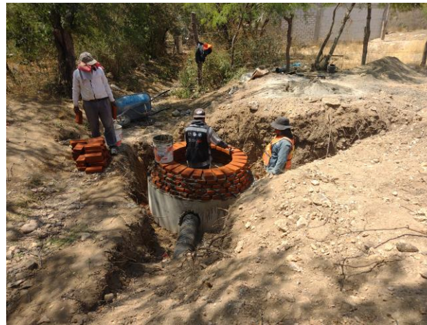
PROCESO DE LA OBRA CON LA CONSTRUCCIÓN DE LOS POZOS DE VISITA DE DIFERENTES ALTURAS
