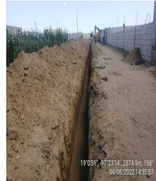
TRABAJOS EXCAVACIÓN EN MATERIAL COMÚN.
