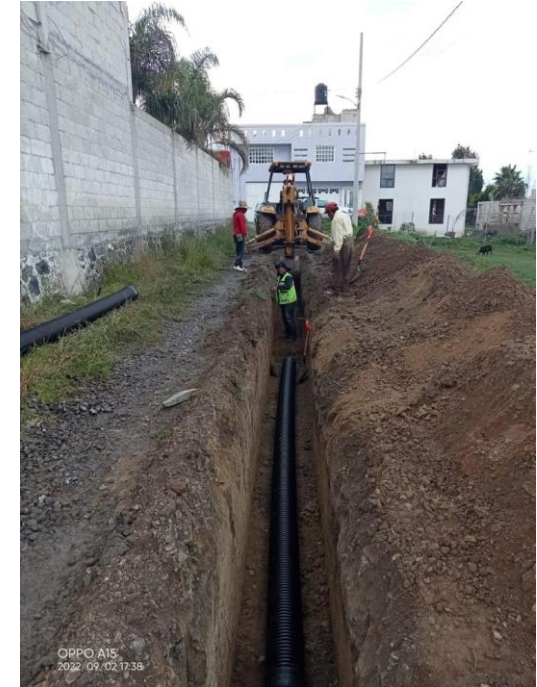
INSTALACIÓN DE TUBERIA PEAD DE ALTA DENSIDAD
