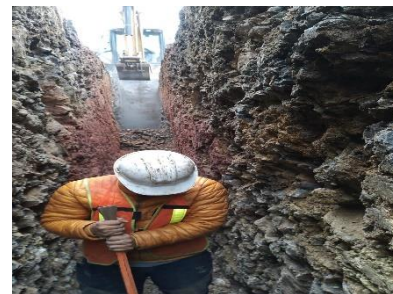
EXCAVACIÓN POR MEDIOS MECÁNICOS PARA LA COLOCACIÓN DE TUBERÍA
