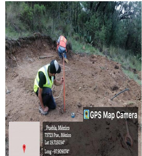
**COLOCACIÓN DE PLANTILLA CON MATERIAL DE BANCO E INSTALACIÓN DE TUBERÍA DE PVC DE 1 ½” DIÁMETRO .**
