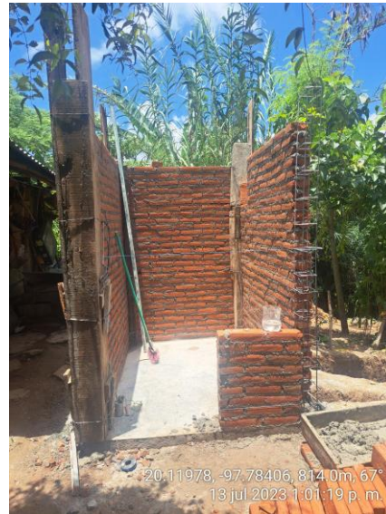
CONSTRUCCION DE CASETA
