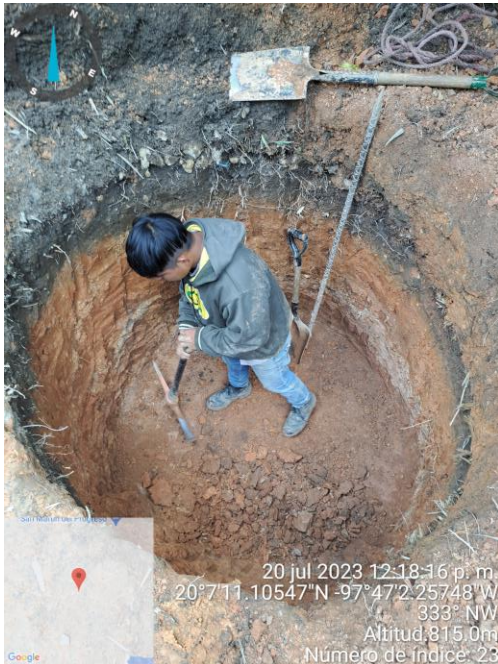
EXCAVACION POZO DE ABSORCION
