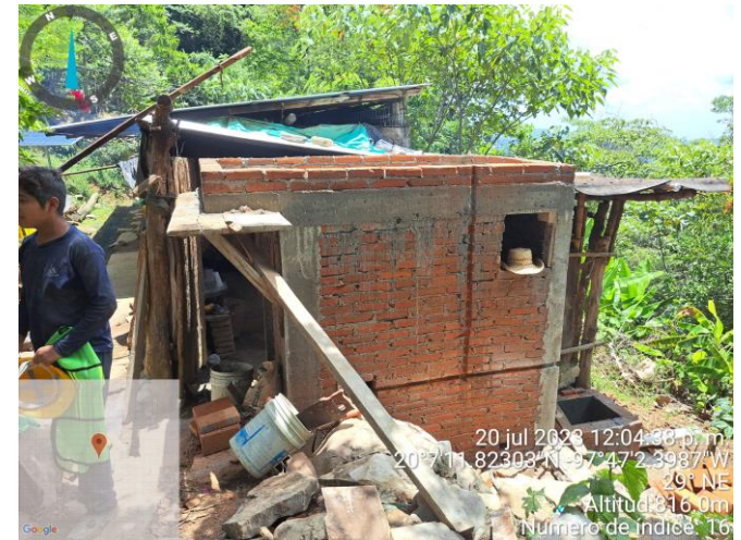
CASETA EN OBRA NEGRA
