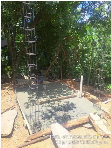
CONSTRUCCION DE LOSA DE DESPLANTE PARA CASETA
