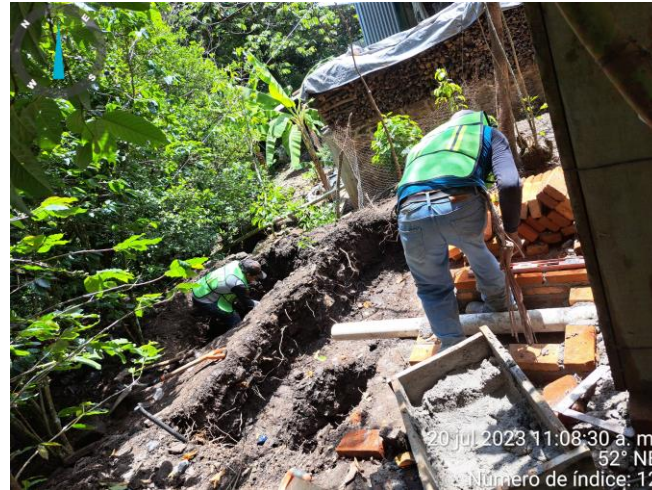
CONSTRUCCION DE REGISTRO
