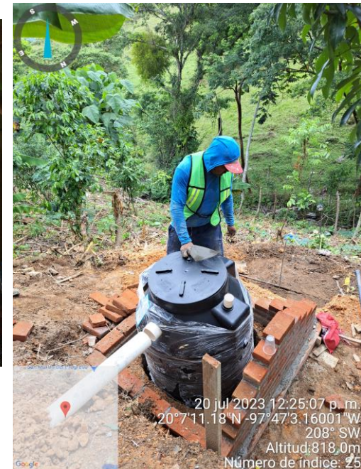
CONSTRUCCION DE REGISTRO PARA BIODIGESTOR
