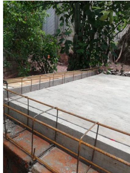
SUMINISTRO Y ABILITADO DE CIMBRA Y AEMEX 15-20
