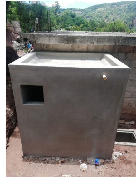
APLANADO CON MORTERO
