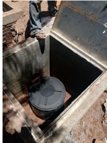
SUMINISTRO E INSTALACIÓN DE REGISTRO DE LODOS
