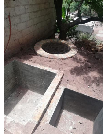
CONSTRUCCIÓN DE REGISTROS Y POZO DE ABSORCIÓN, SISTEMA DE TRATAMIENTO
