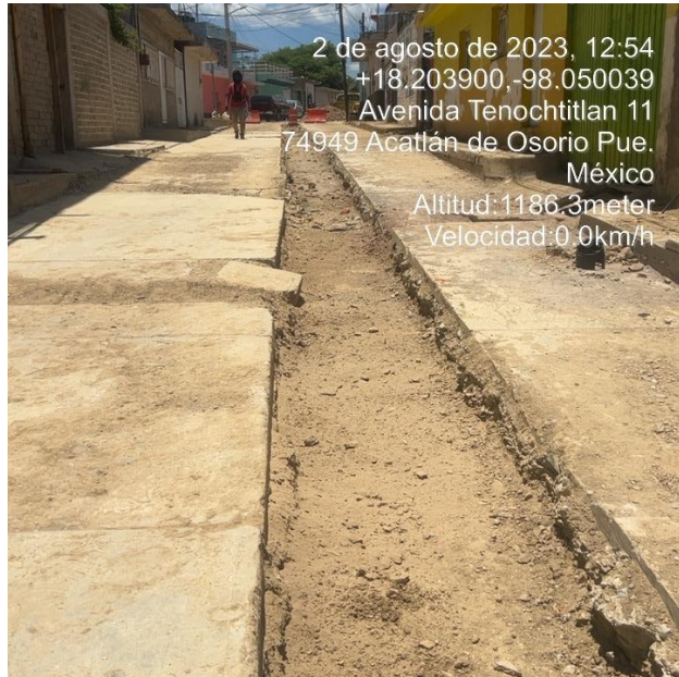
PREPARACIÓN DE ZANJA PARA RECIBIR BASE HIDRÁULICA
