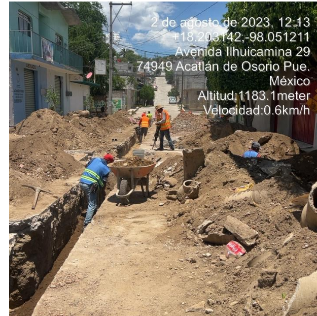
RELLENO Y COMPACTACIÓN POR CAPAS
