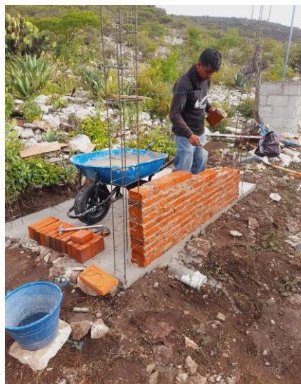
PROCESO DE CONSTRUCCIÓN DE MUROS DE TABIQUE PARA CASETA DE BAÑO
